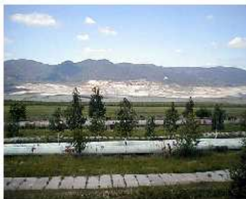
Obr. 7. Řeka Bílina v potrubí
