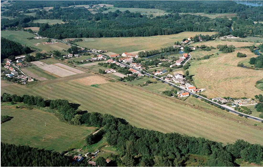
Obr. 1. Letecký snímek obce Majdalena (48°57'49,903''N, 14°51'34,591''E)
