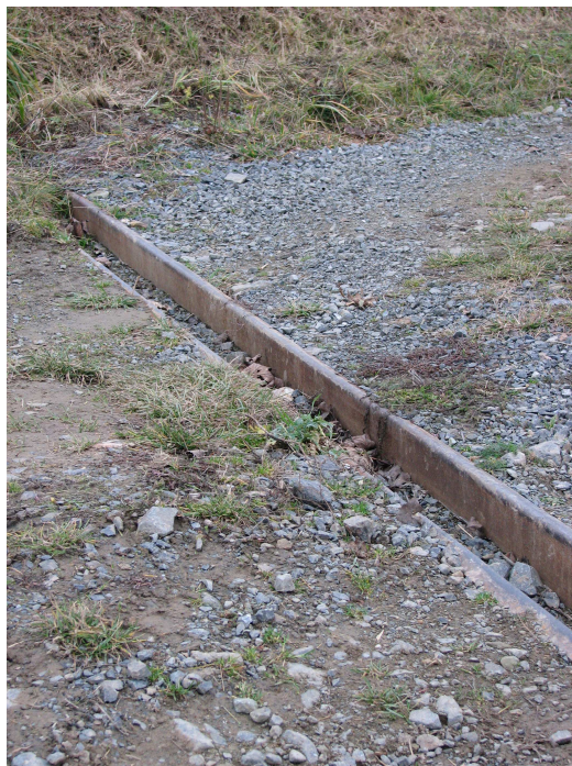
Obr. 5.4 a 5.5: Rekonstruovaná HPC 1 (levý obrázek), detail odvodňovacího žlábků (obrázek vpravo)
