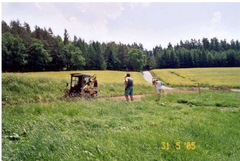
Obr. 10.13: VPC 5 – pohled na křižovatku – počátek zemních prací – 31.5. 2005
