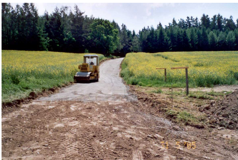
Obr. 10.14: VPC 5 – pohled na křižovatku, počátek zemních prací – 31.5. 2005
