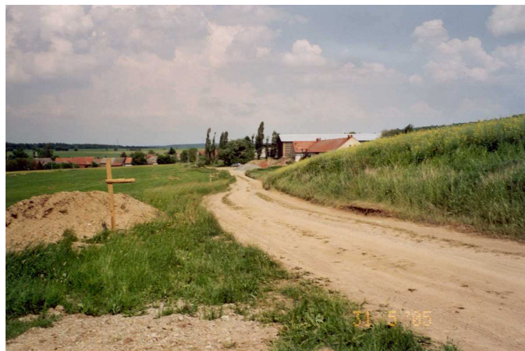
Obr. 10.11: VPC 5 – pohled směrem k obci, počátek zemních prací – 31.5. 2005
