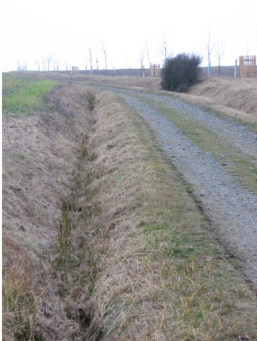
Obr. 5.4 a 5.5: Rekonstruovaná HPC 1 (levý obrázek), detail odvodňovacího žlábků (obrázek vpravo)
