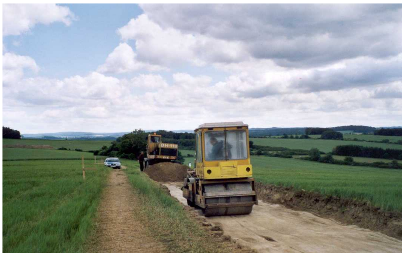
Obr. 10.5: VPC 4 „Hřebenovka“ – začátek zemních prací – od lesa k remízu 10.6. 2005
