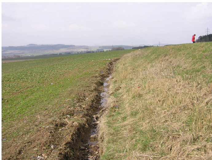
Obr. 10.4: Přívod vody od propustku do průlehu (rovnoběžně se silnicí) – duben 2006
