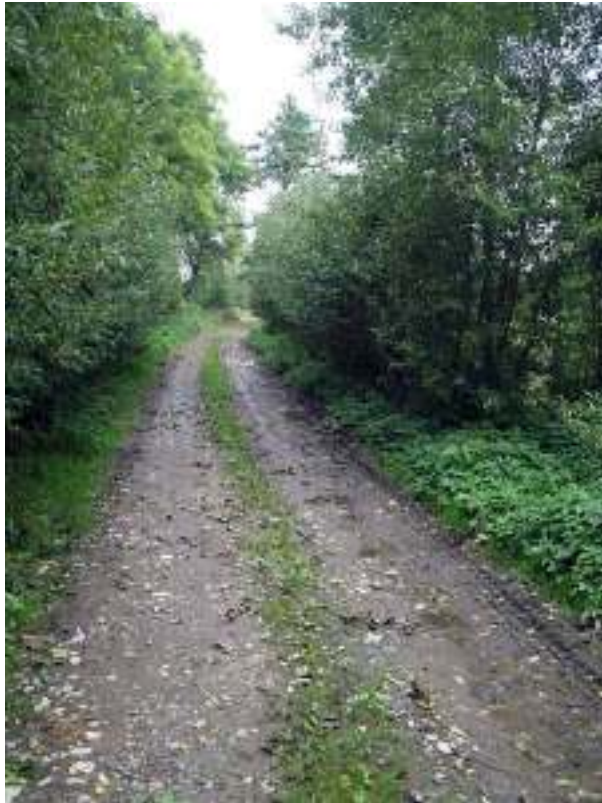
obr. č.3: Hlavní polní cesta HPC-1, 1. část
