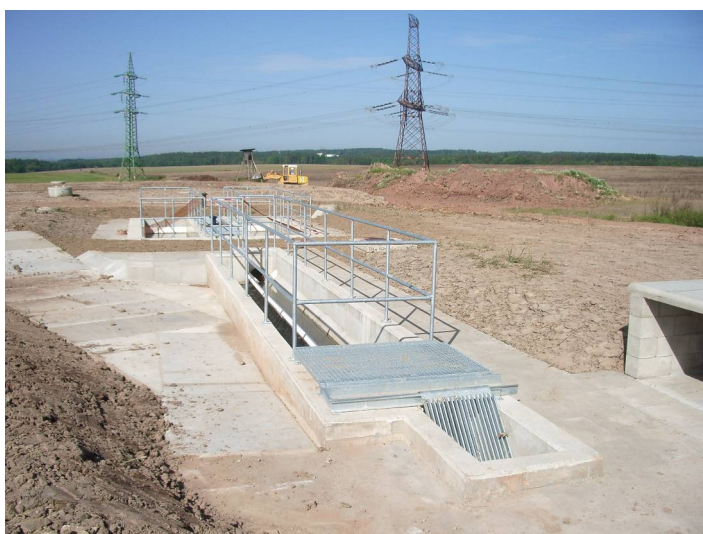
Obr. č. 22: Výstavba ČOV v Libníči
