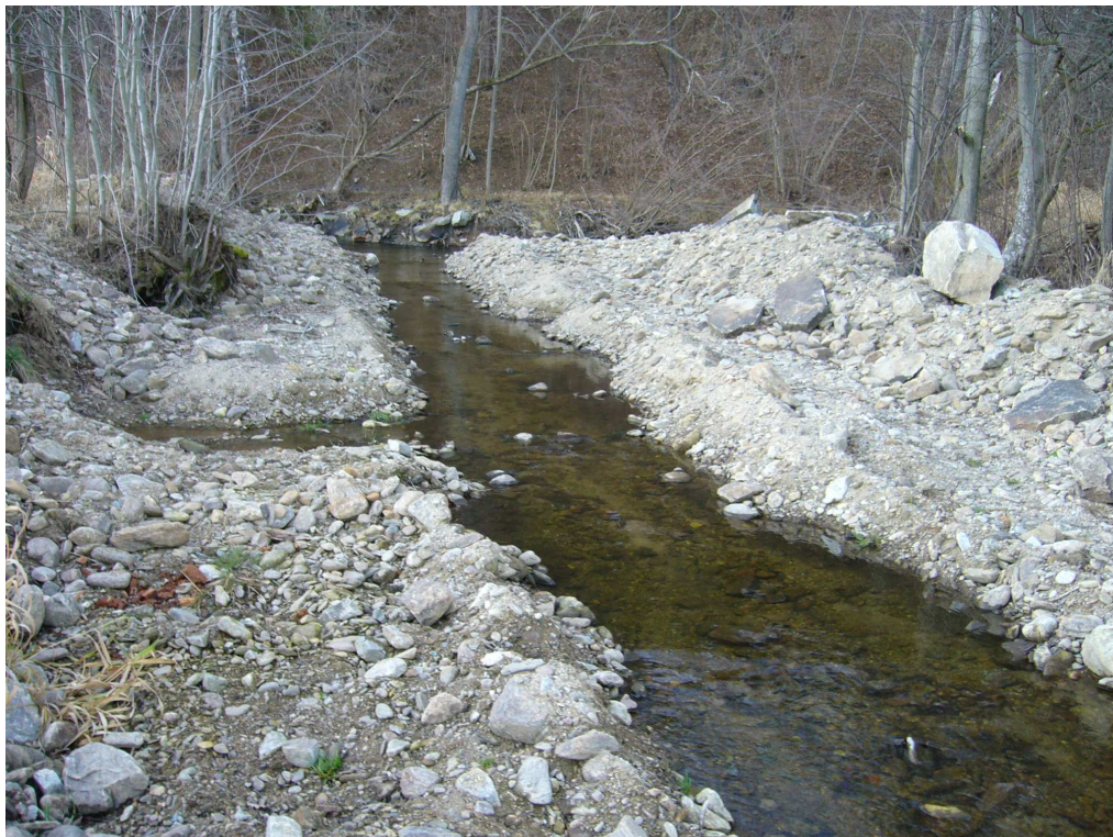
Obr. 30 Lokalita č. 4 – Blanice u obce Záblatí – Drastická regulace 50 m toku, kde byl 23.6.2004 proveden odlov ještě v neupraveném korytě.
