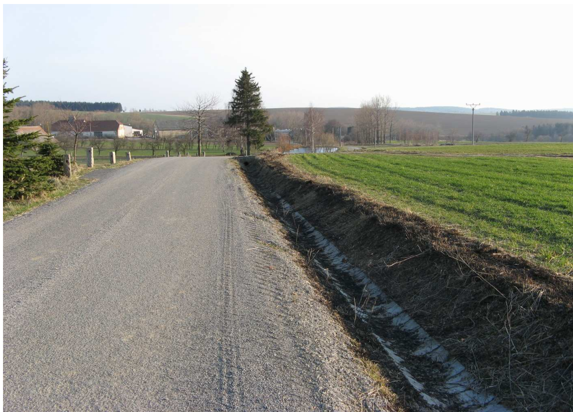
Obrázek č. 4: Hlavní cesta C3, cestní příkop P5, propustek M16, v pozadí nádrž N4
