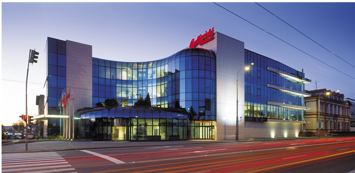
Obrázek 1: Večerní pohled na novou budovu Budějovického Budvaru.
