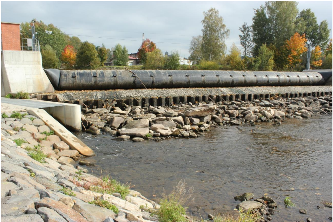
Obr. 5 Vstup do rybího přechodu vedle vakového jezu při nedodržování MZP (Foto: autor).
