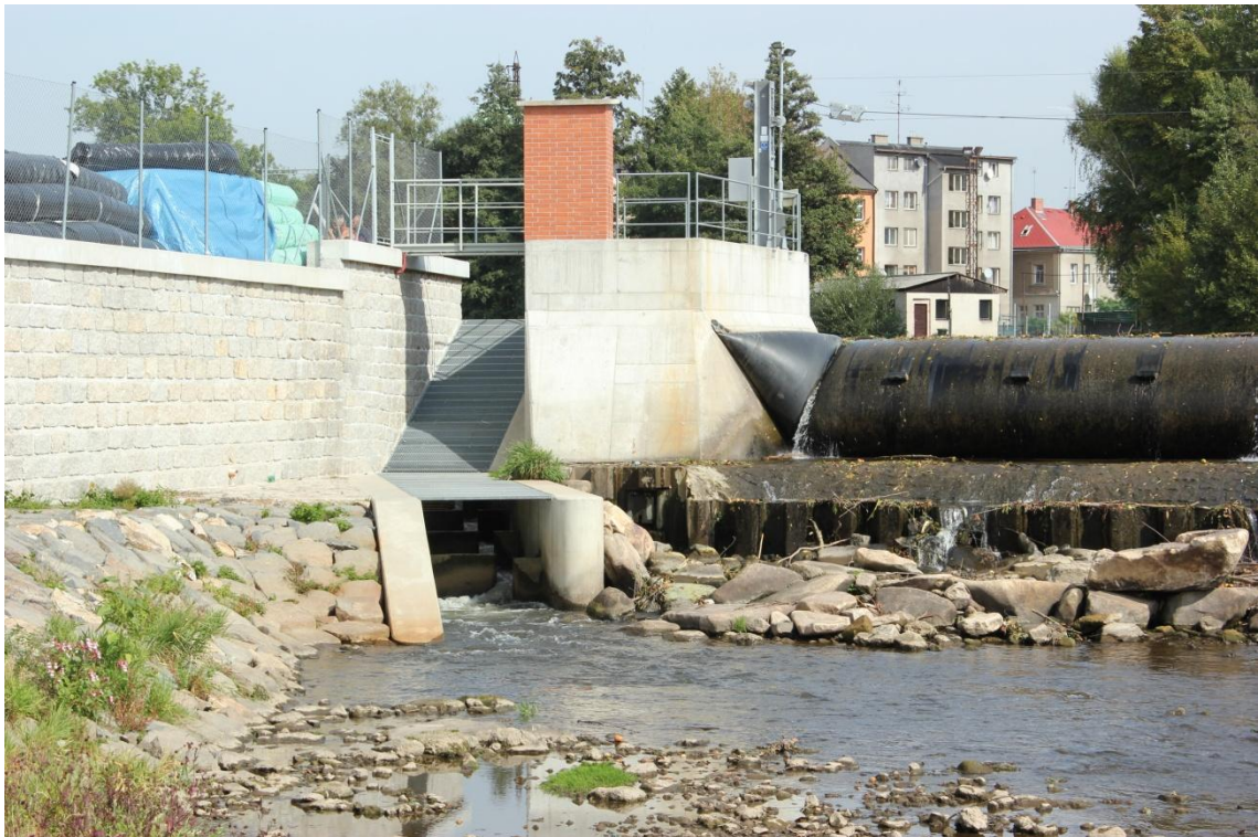
Obr. 9 Umístění vstupu do RP v těsné blízkosti paty jezu (Foto: autor).
