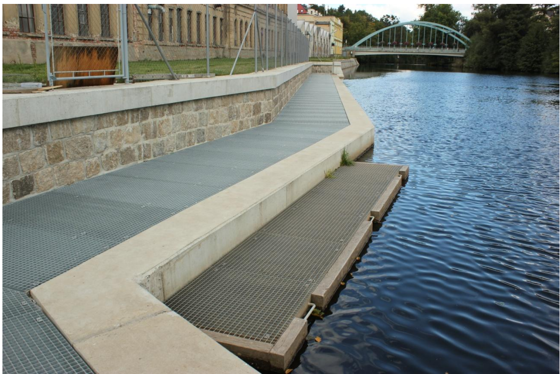
Obr. 2 Trasa rybího přechodu překrytá pororošty s molem pro vodáky (Foto: autor).
