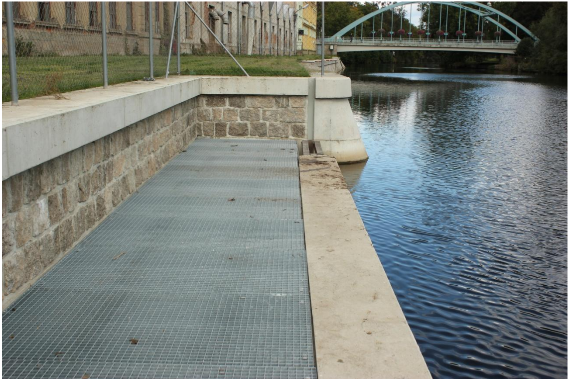
Obr. 3 Výstup z rybího přechodu v nadjezí (Foto: autor).
