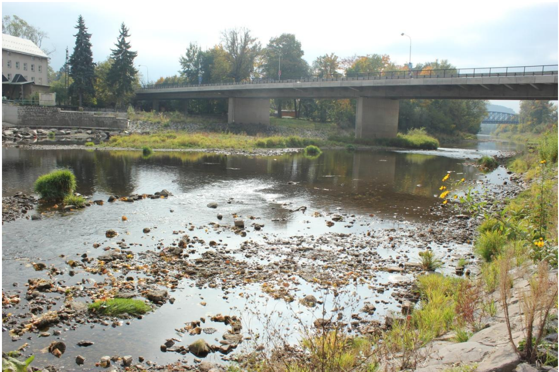
Obr. 6 Oblast podjezí při nedodržování MZP (Foto: autor).
