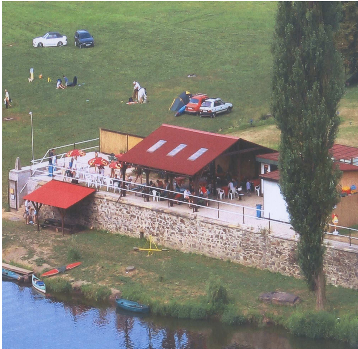
Obrázek č. 1 – Pohled na stávající kiosek s terasou
