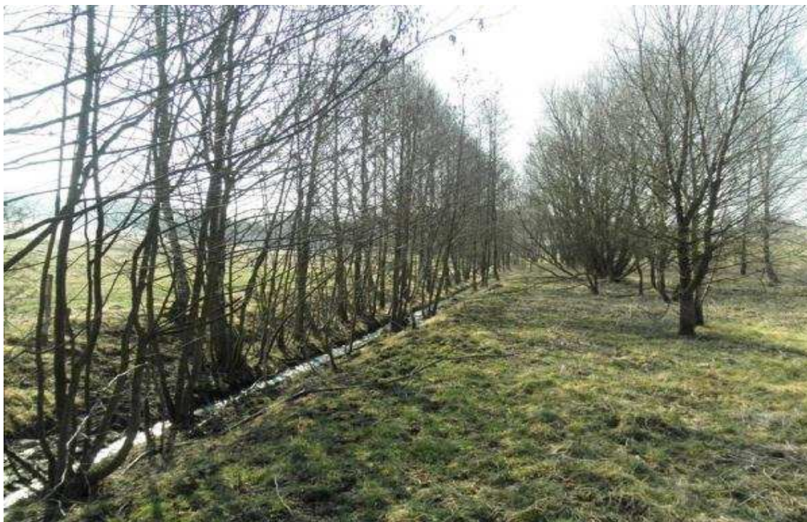
Obr. č. 11. Všeměřický potok před úpravou, úsek pod Horním všeměřickým rybníkem.
