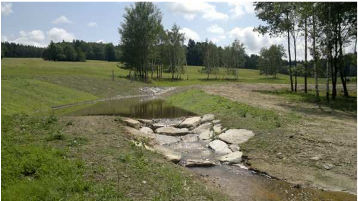
Obr. č. 24. Všeměřický potok, pod Horním všeměřickým rybníkem, tůň navazující na bezpečnostní přeliv.
