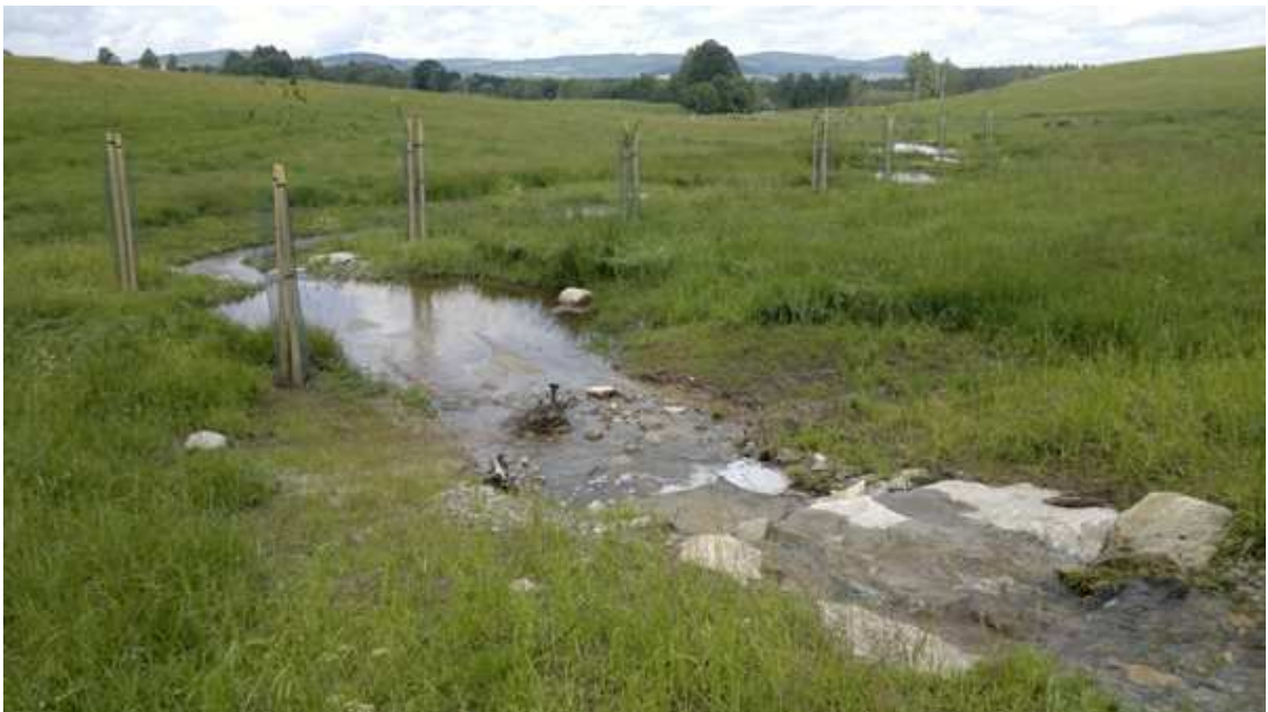
Obr. č. 26. Všměřický potok, úsek nad Horním všměřickým rybníkem, po provedení vegetačních úprav.
