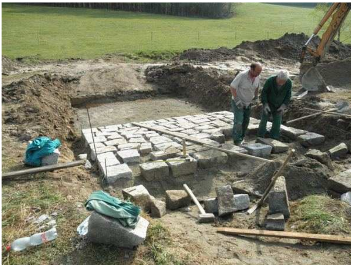
Obr. č. 17. Všeměřický potok, stavba kamenného brodu.
