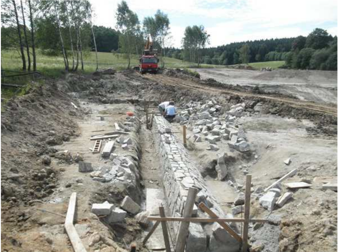
Obr. č. 19. Horní všeměřický rybník, stavba bezpečnostního přelivu.
