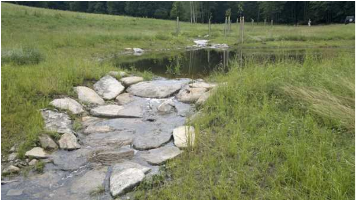
Obr. č. 28. Všeměřický potok, úsek nad Horním všeměřickým rybníkem, ohraničení tůňí kamennými stupni.
