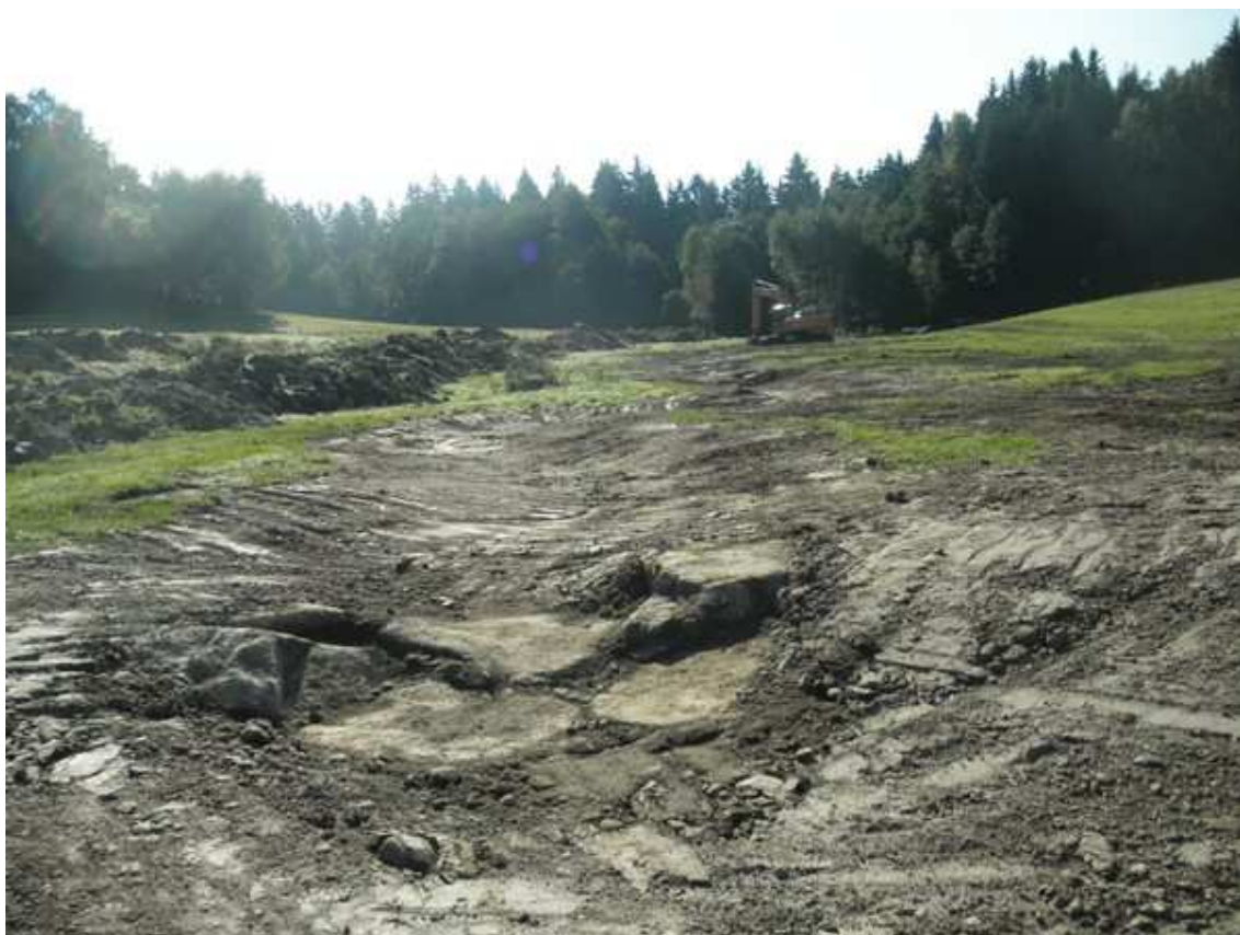
Obr. č. 21. Všeměřický potok, úsek nad Horním všeměřickým rybníkem, vytváření prahů.
