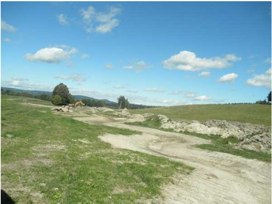
Obr. č. 20. Všeměřický potok, úsek nad Horním všeměřickým rybníkem, rozvlňování koryta.
