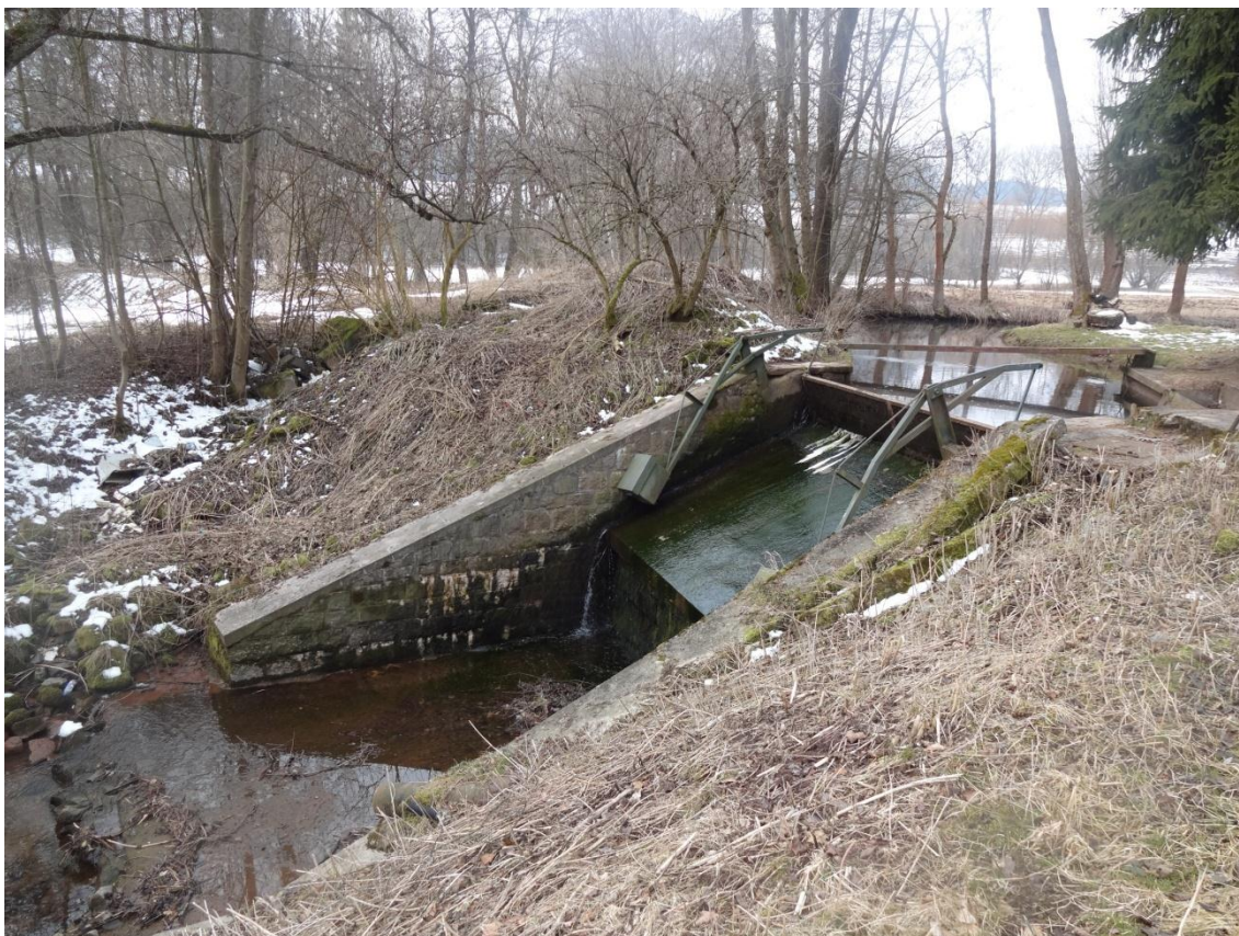
Obr. 10 Vzdouvací objekt MVE p. Lánský na toku Popelka (foto autor).
