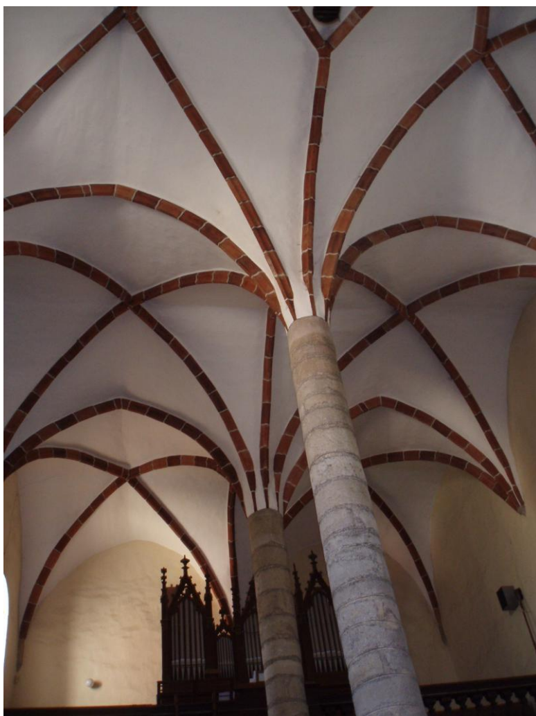
Obrázek č. 15: Klenba obou lodí s opěrnými pilíři
