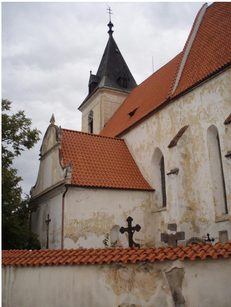
Obrázek č. 19: Pohled na předsíň při jižní stěně kostela
