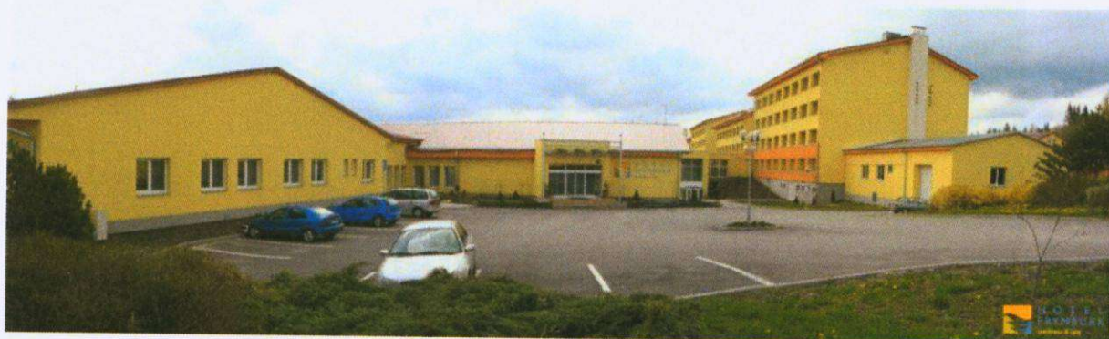
Pohled z východní strany
