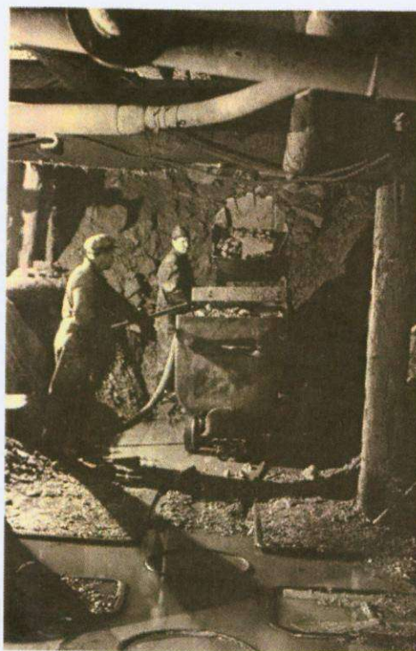
Práce v podzemí
