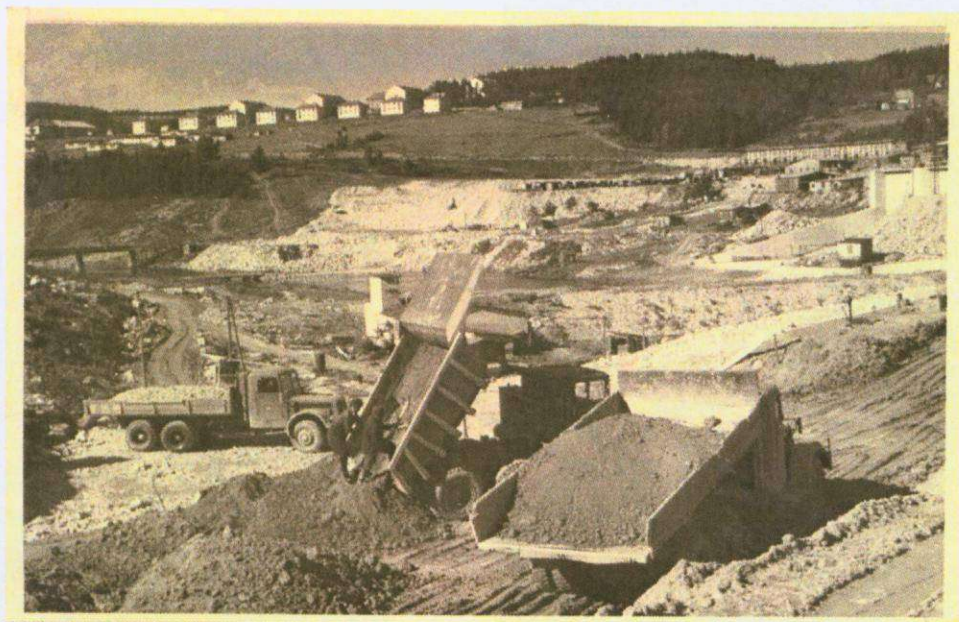
Sypání hráze, v pozadí ubytovny pro pracovníky v Lipně nad Vltavou
