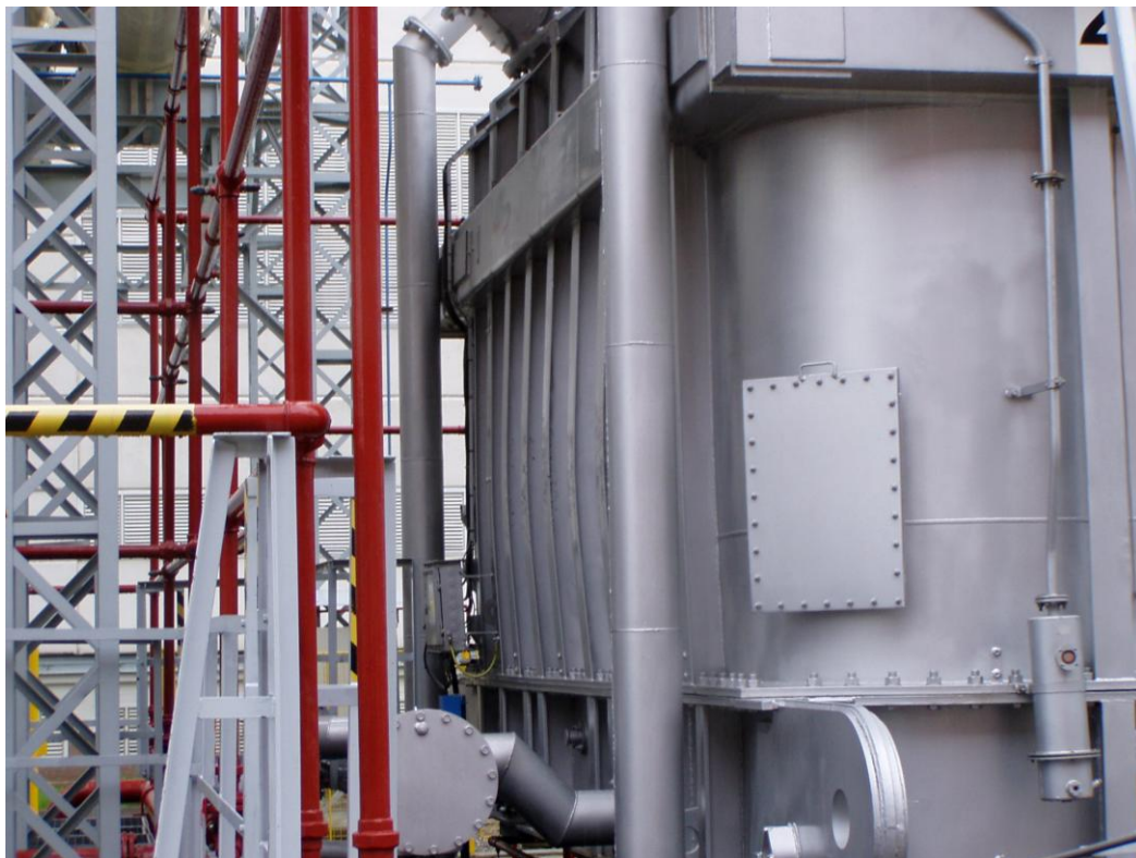
Obrázek č.1 Poškozená (vypouklá) nádoba, č.2 Poškozená průchodka 24 kV
