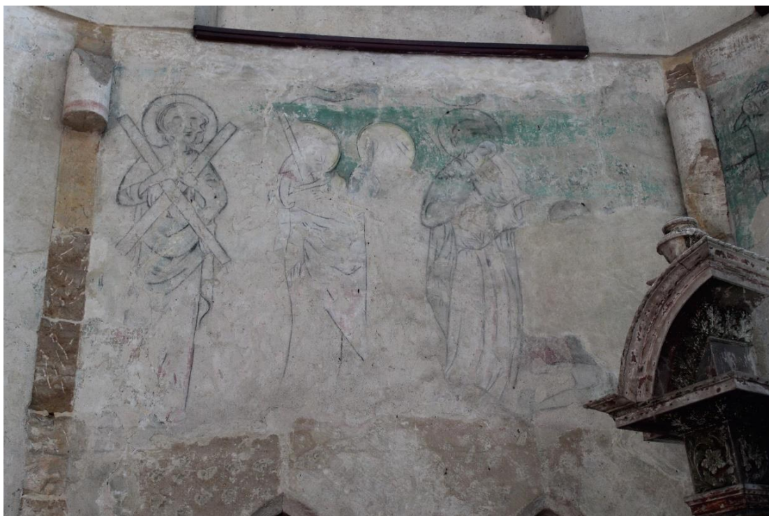
31. Hrad Houska: pohled na detail fresky z prostoru kněžiště
