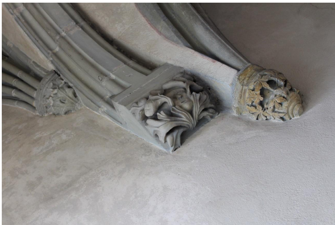
43. Hrad Křivoklát: detail konzol v prostoru bývalé předsíně
