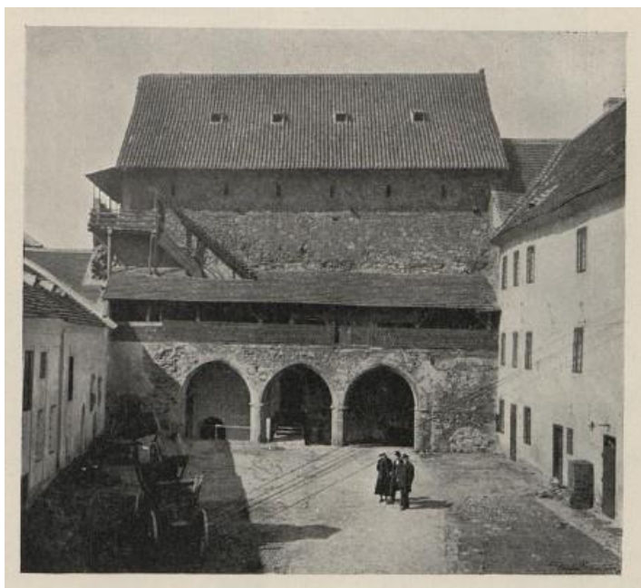
6. Západní palácové křídlo – vstup do druhého patra (venkovní schodiště vedoucí z arkádového ochozu)
