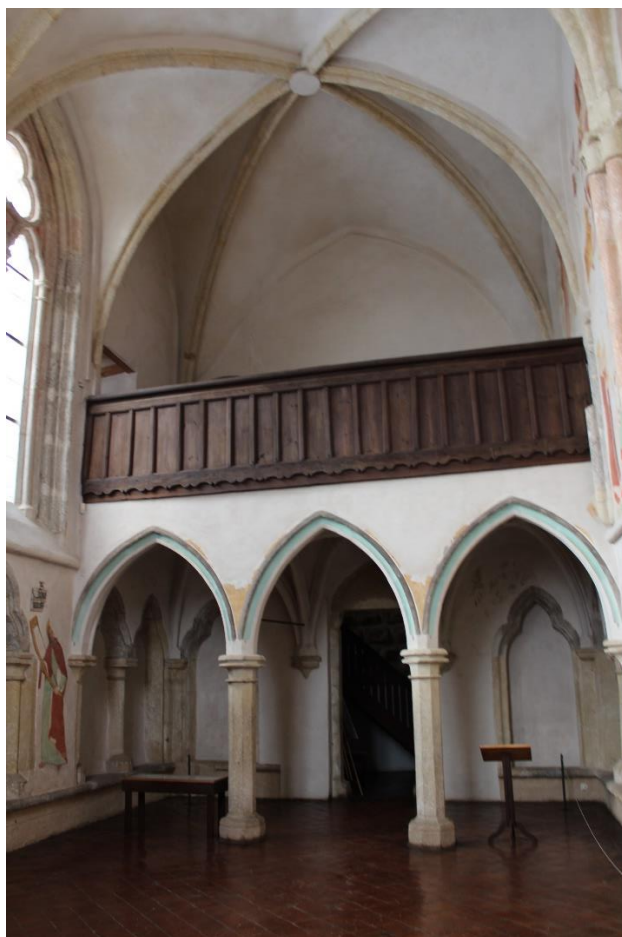
21. Hrad Zvíkov: pohled na emporu, na západní straně kaple
