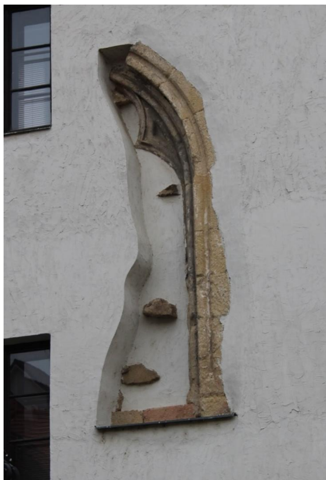
12. pozůstatek vstupního portálu v prvním patře - detail
