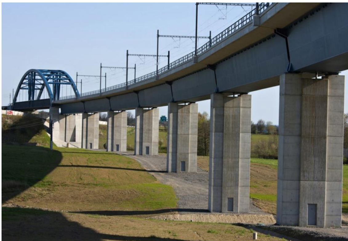
Obrázek 10: Železniční most koridoru
