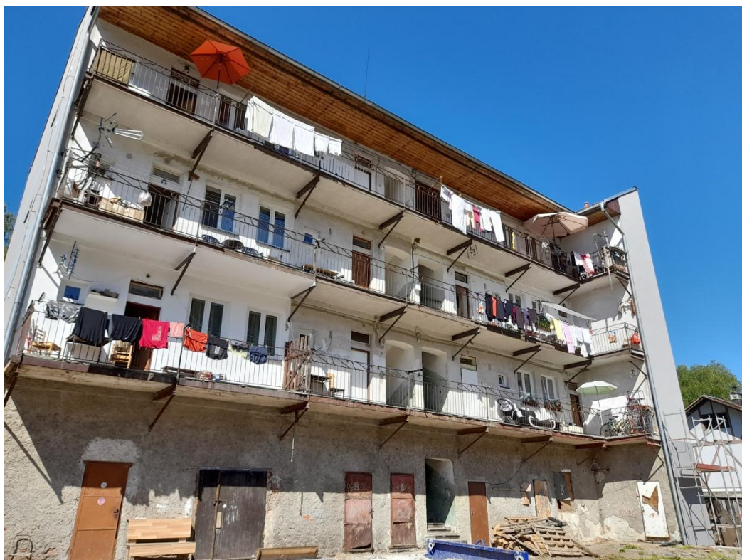
Obr. 15: Pavlačový dům v Rožmberské ulici, 19. 7. 2022.
