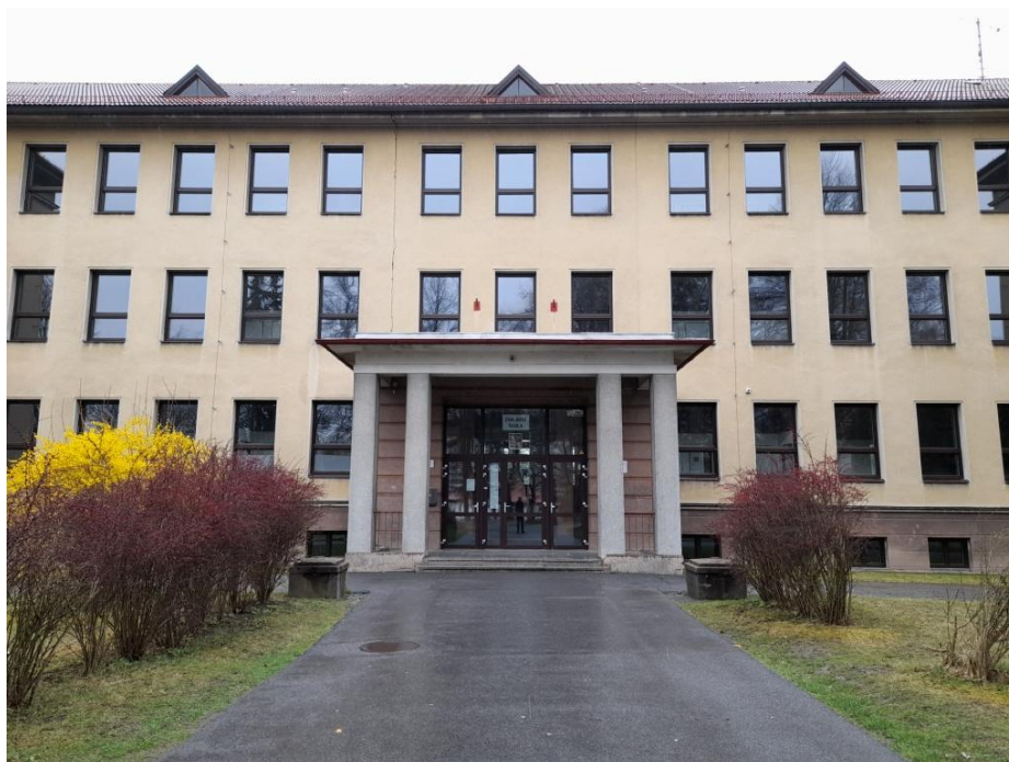
Obr. 1: Vstup do budovy ZŠ Větrný, 19. 4. 2022.
