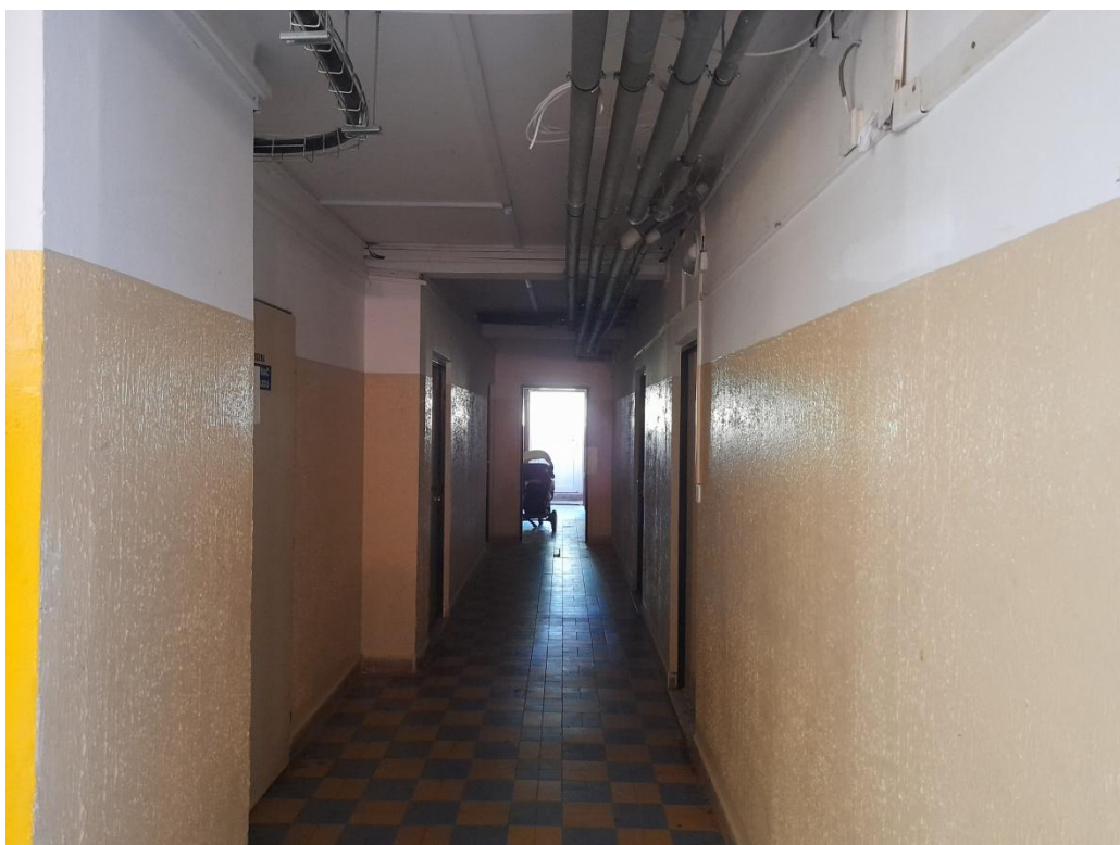
Obr. 18: Chodba panelového domu v Šumavské ulici, 19. 7. 2022.
