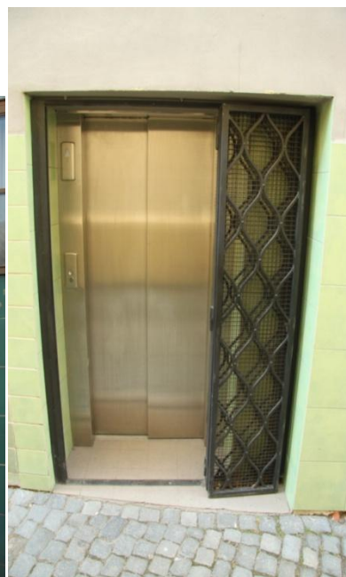
Foto 2: Boční výtah MěÚ
