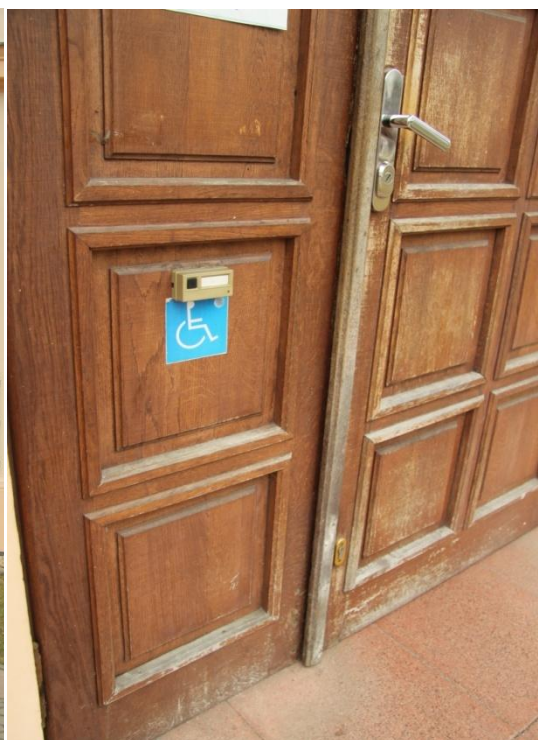
Foto 2: Detail vstupu do budovy MěÚ a ÚP
