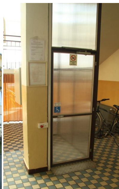
Foto 7: Výtah v budově školy
