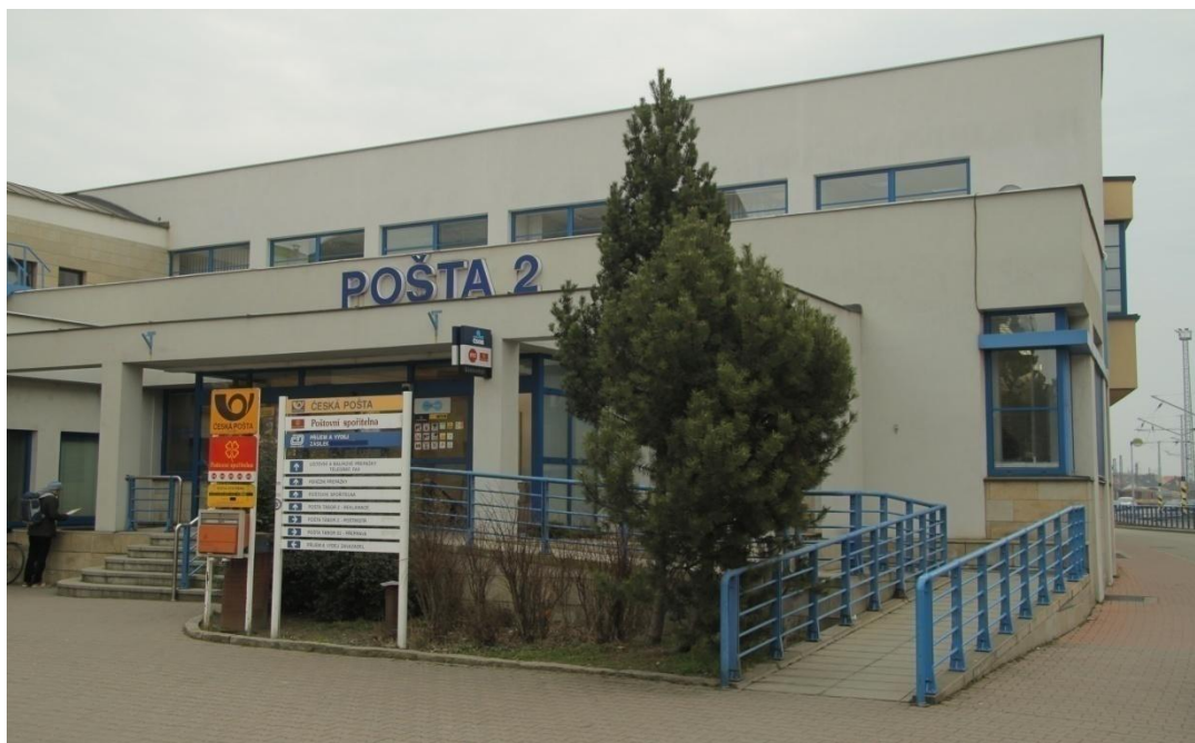
Foto 6: Nájezdová rampa vedoucí ke vstupním dveřím do budovy pošty
