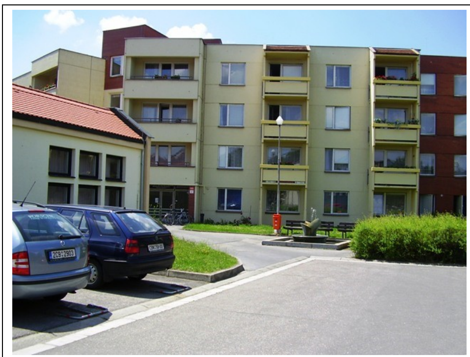
Obr. č. 1 – Pohled na CSS Staroměstská v Českých Budějovicích.
