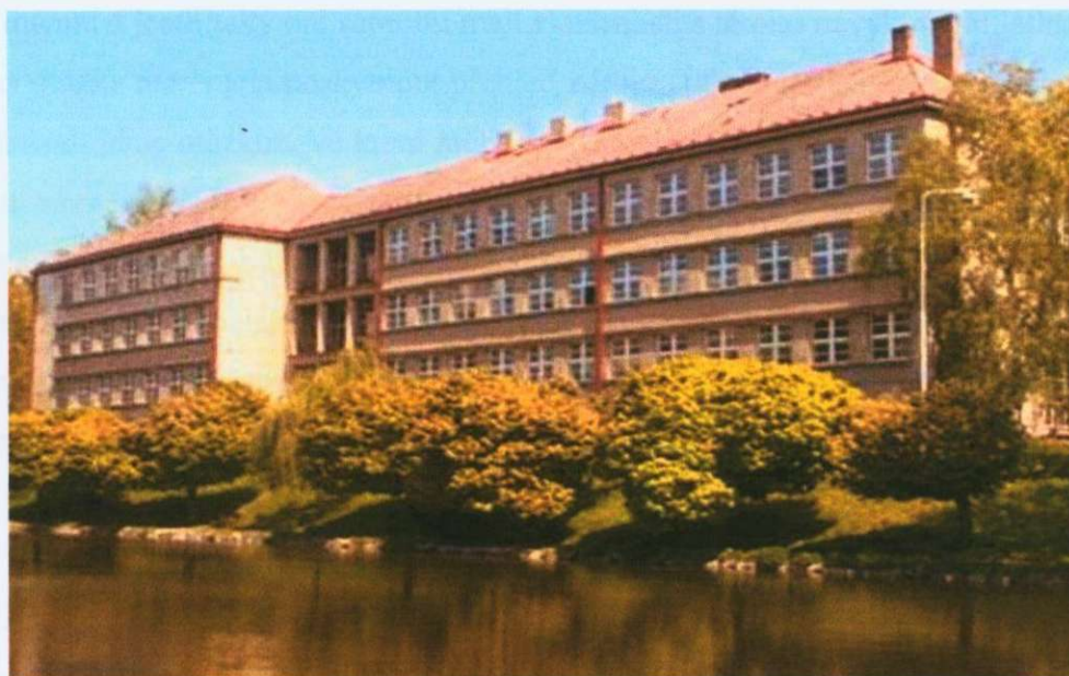
Obr. 2 Celkový pohled na ZŠ V Sadech
