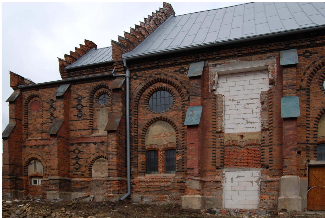
Pohled na jižní stranu Nové synagogy, je zde vidět zazděná díra po nákladním výtahu, který zde zbudovala Jednota LSD
