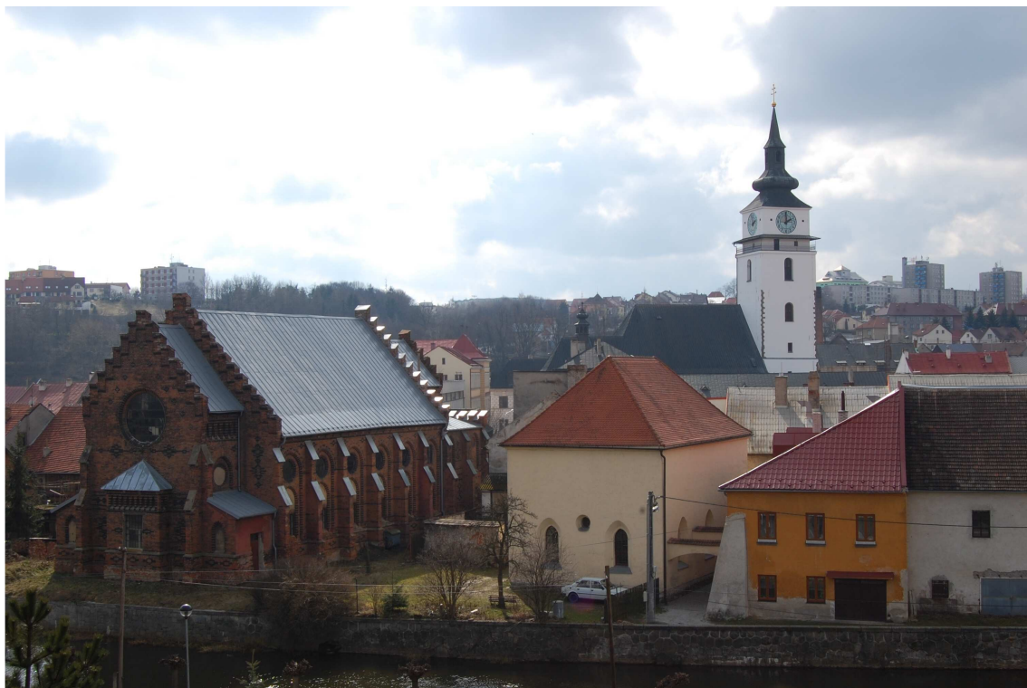
Zadní průčelí Staré a Nové synagogy i s pohledem na křesťanský kostel
