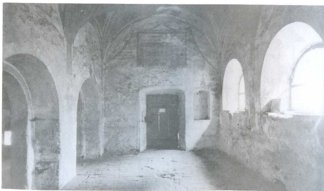
Původní vzhled interiéru ženské galerie Staré synagogy, 1943, foto MSD Velké Meziříčí
