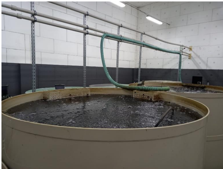
Obr. č. 32 Nádrže s biofiltračními elementy (foto R. Gebauer)
