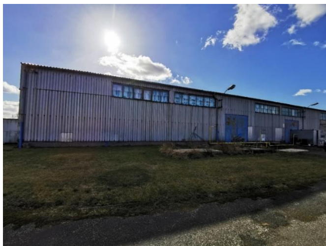
Obr. č. 10 Hala s akvapponickým systémem v Řisutech
