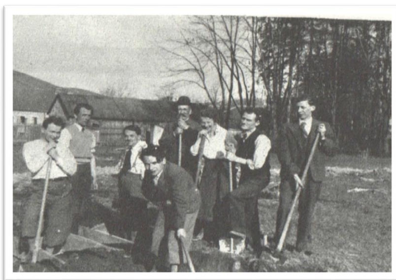
Obrázek 9. Sokolové při budování hřiště v polovině třicátých let. Zdroj: Vimperk - město pod Boubínem (1979).
