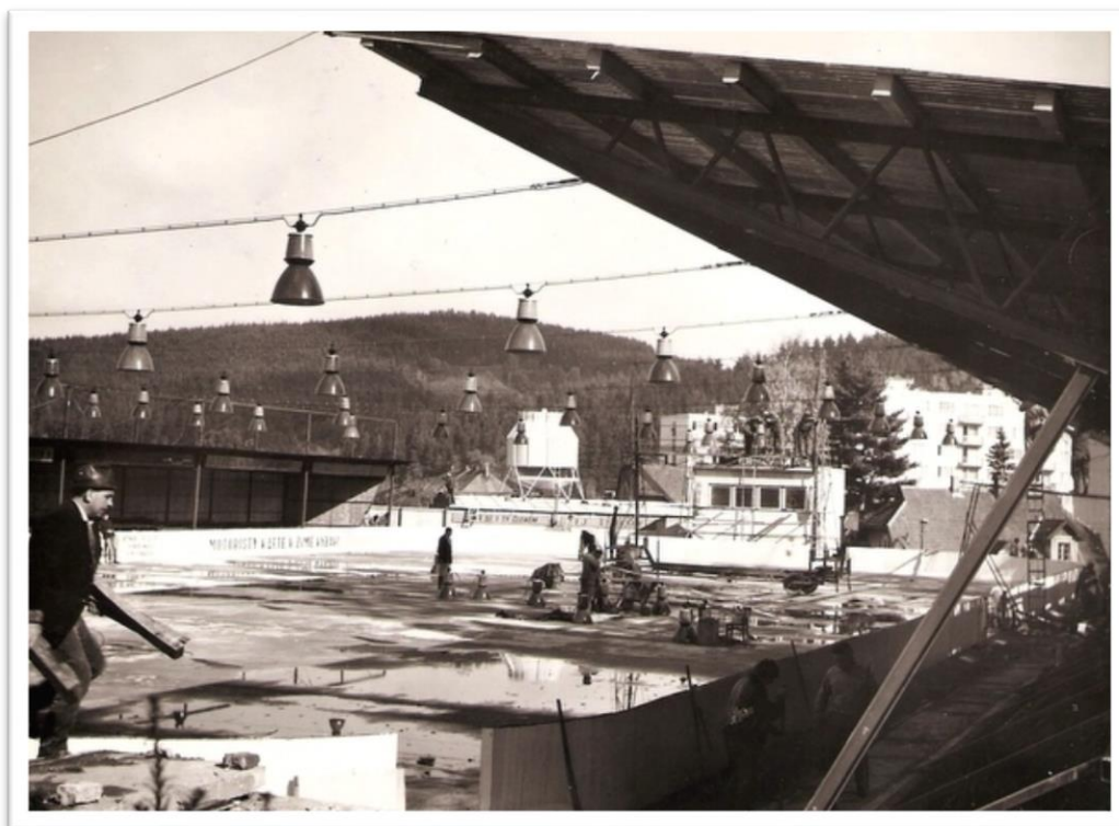
Obrázek. 16 Budování vimperského zimního stadionu. Zdroj: http://zakrasnejsivimperk.cz/?p=3753 .
