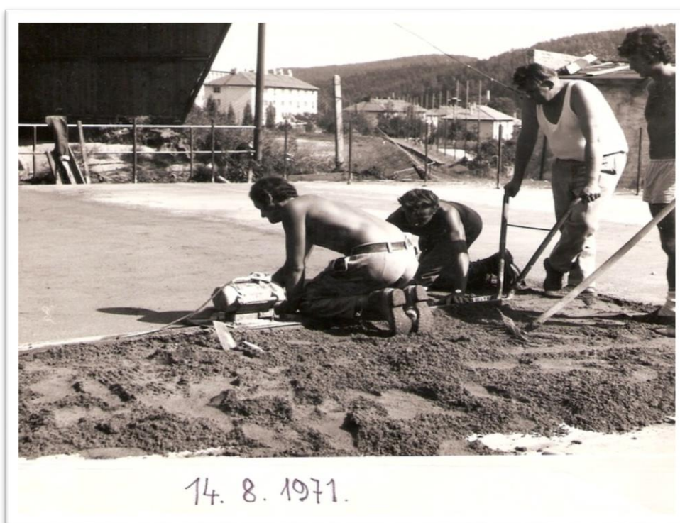
Obrázek 15. Budování vimperského zimního stadionu . Zdroj: http://zakrasnejsivimperk.cz/?p=3753 .
