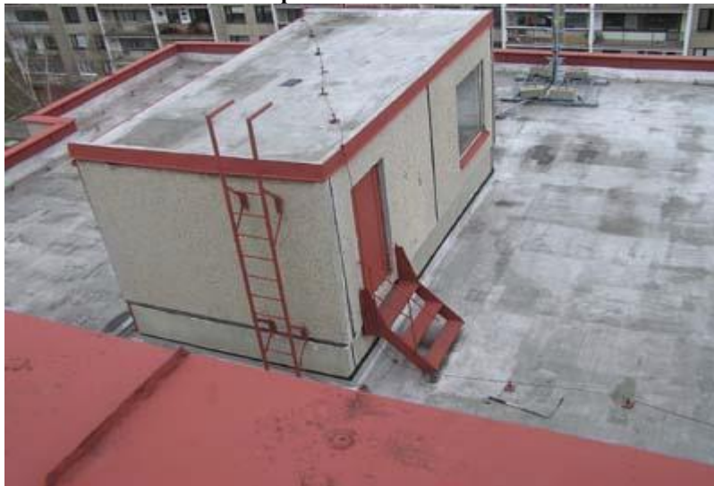
Obrázek 1: Plochá střecha panelového domu
