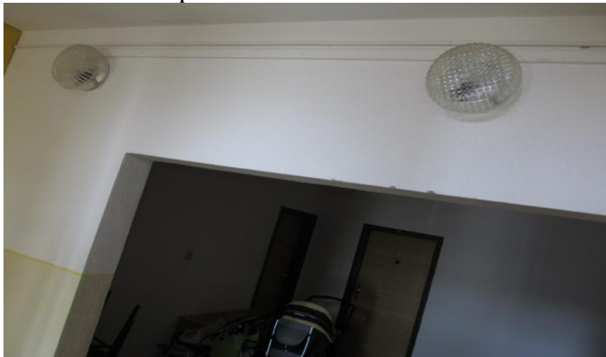
Obrázek 4: Chodba v panelovém domě
