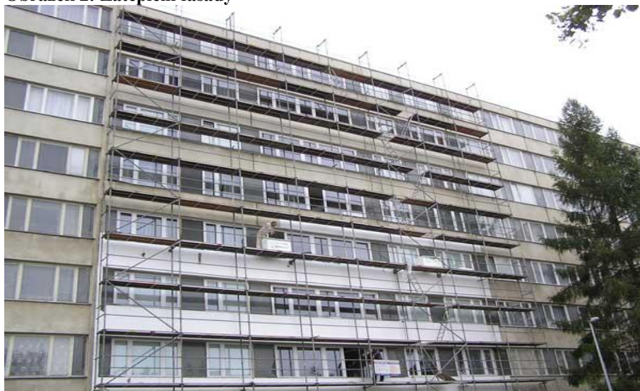
Obrázek 2: Zateplení fasády
