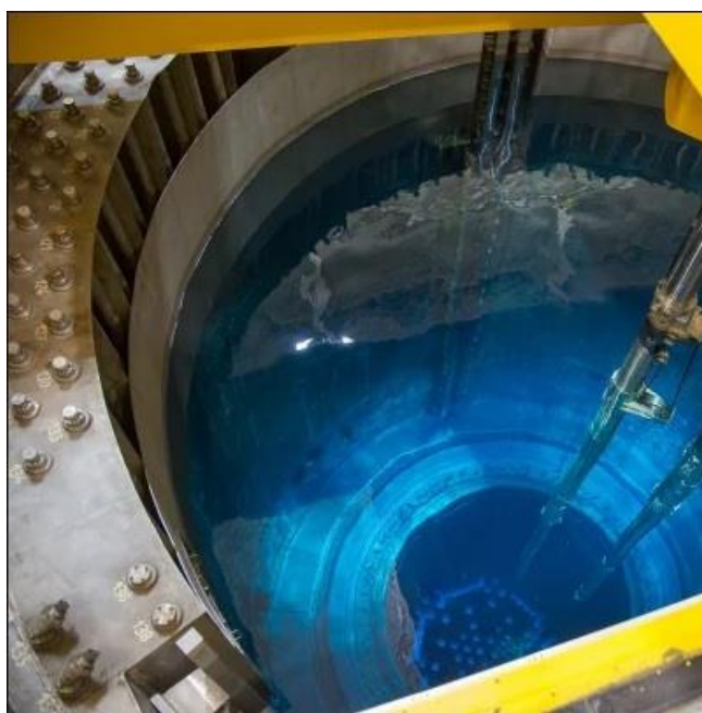
Obrázek 4 - Ukázka ramena zavážecího stroje při přesunu palivové kazety z reaktoru do BSVP [1]
