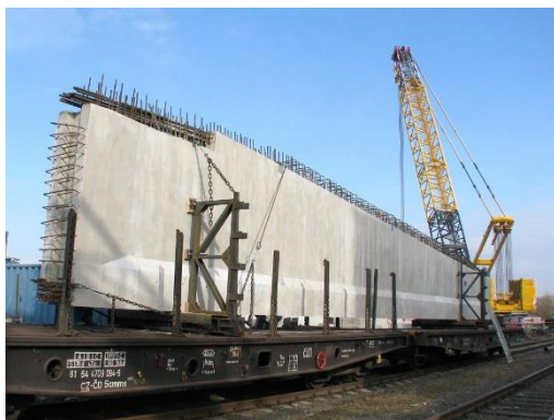
Obrázek 7 - Ukázka nakládání vazníků na vagón [10]
