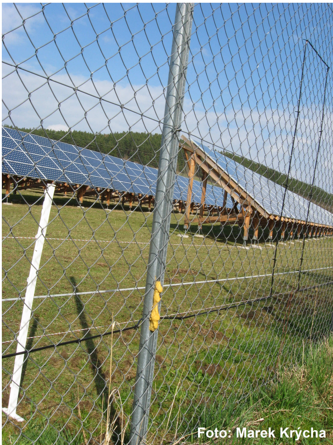
Foto 3 – Pohled na dřevěnou konstrukci s upevněnými fotovoltaickými panely a na pachovou značku pro odpuzování divoké zvěře aplikovanou na sloupku oplocení
