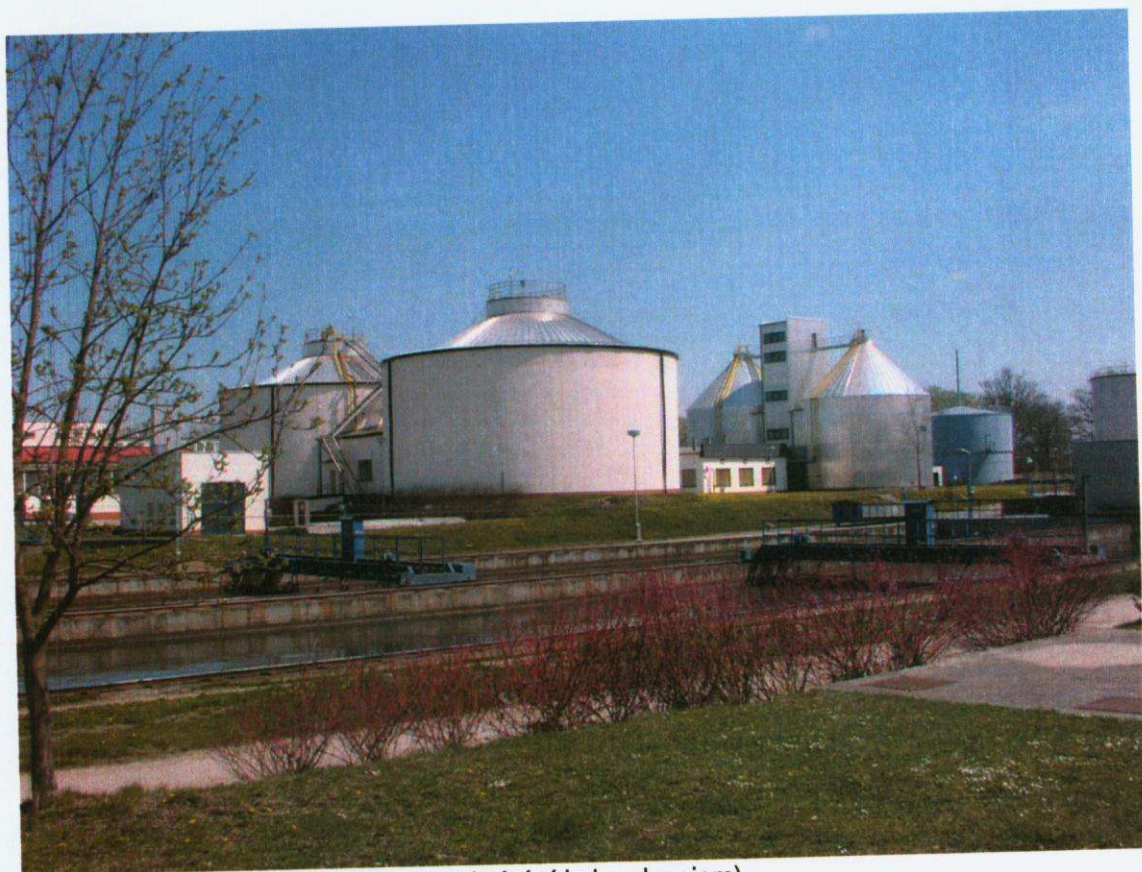
ČOV České Budějovice (Nádrže na vyhnívání kalu, plynojem)
