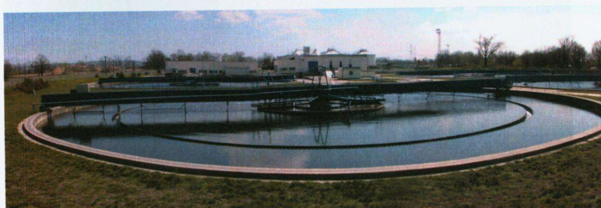
ČOV České Budějovice (dosazovací nádrže)
