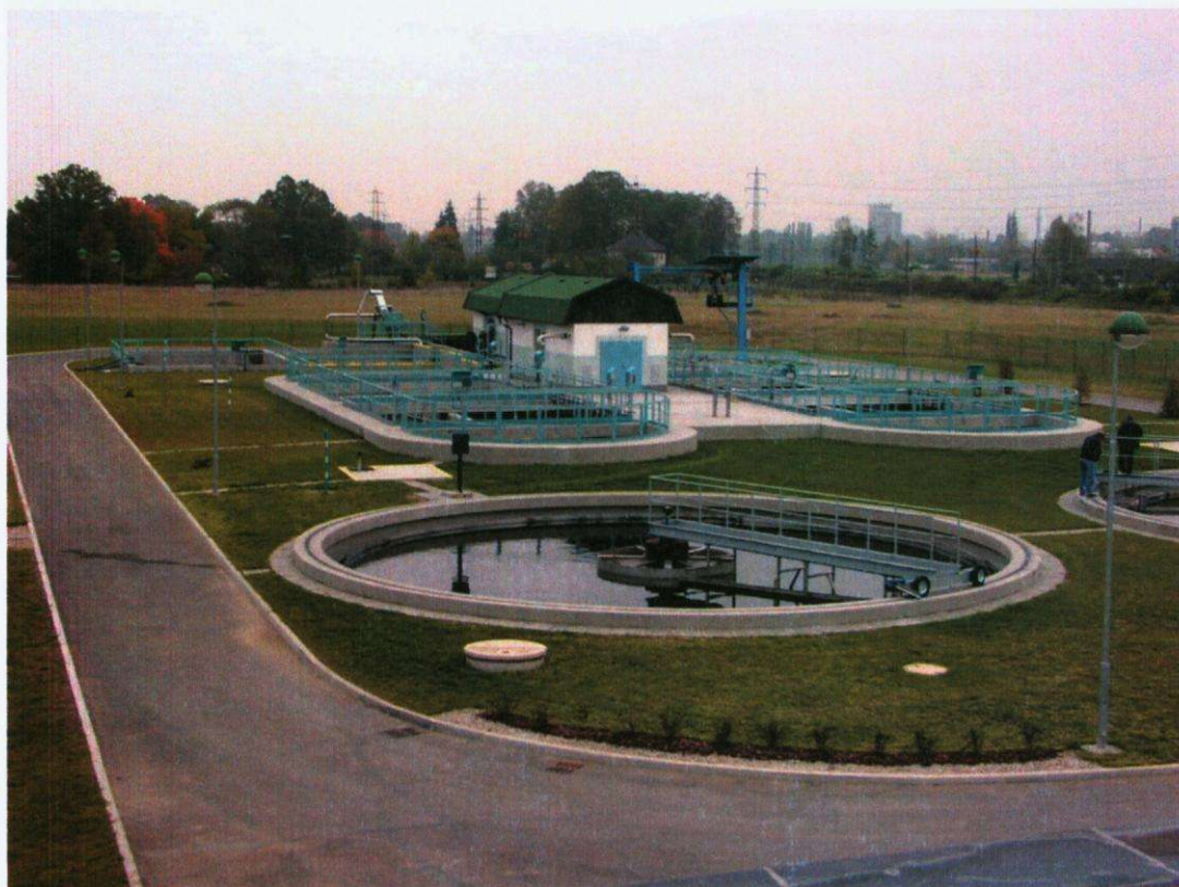
ČOV Přelouč (kruhové dosazovací nádrže, oběhové aktivační nádrže a hrubé předčištění)
