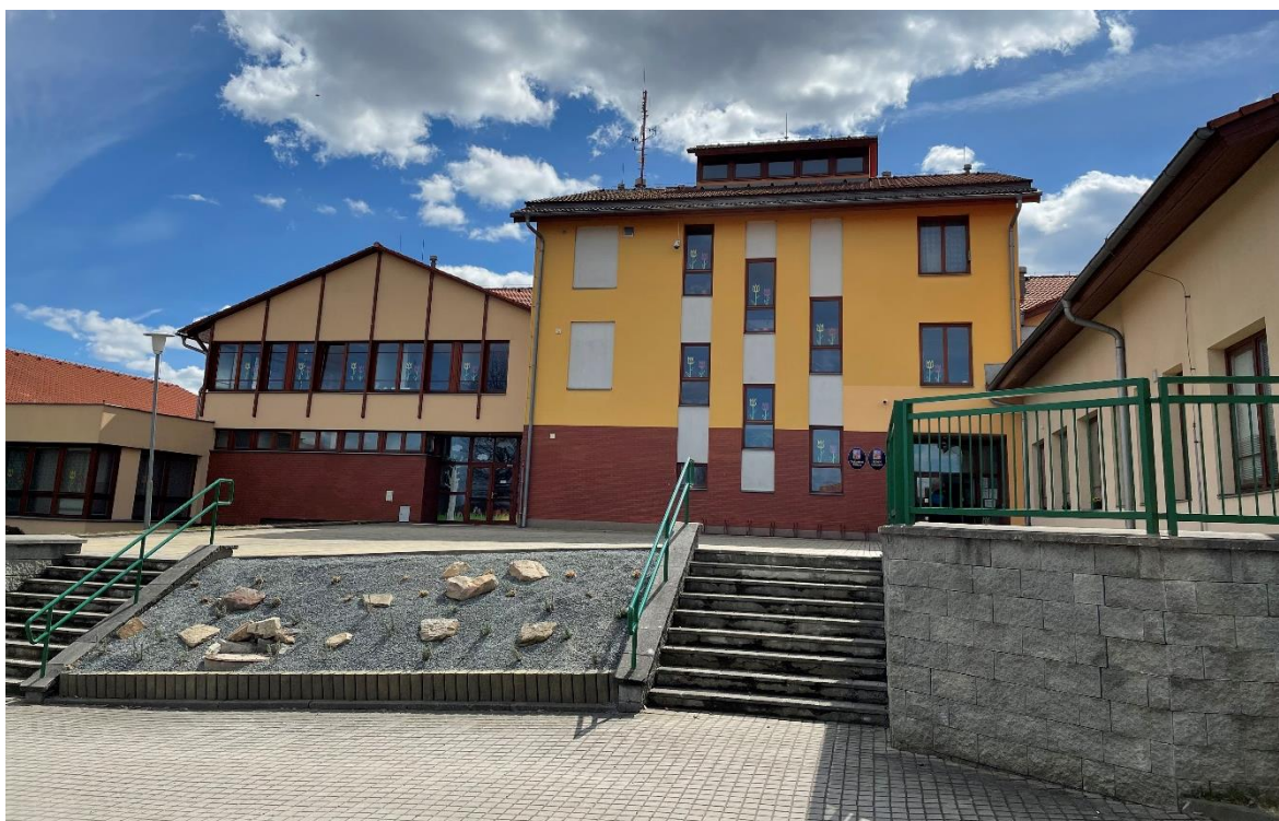
Obrázek 24 - Moderní budova ZŠ Lukavec
