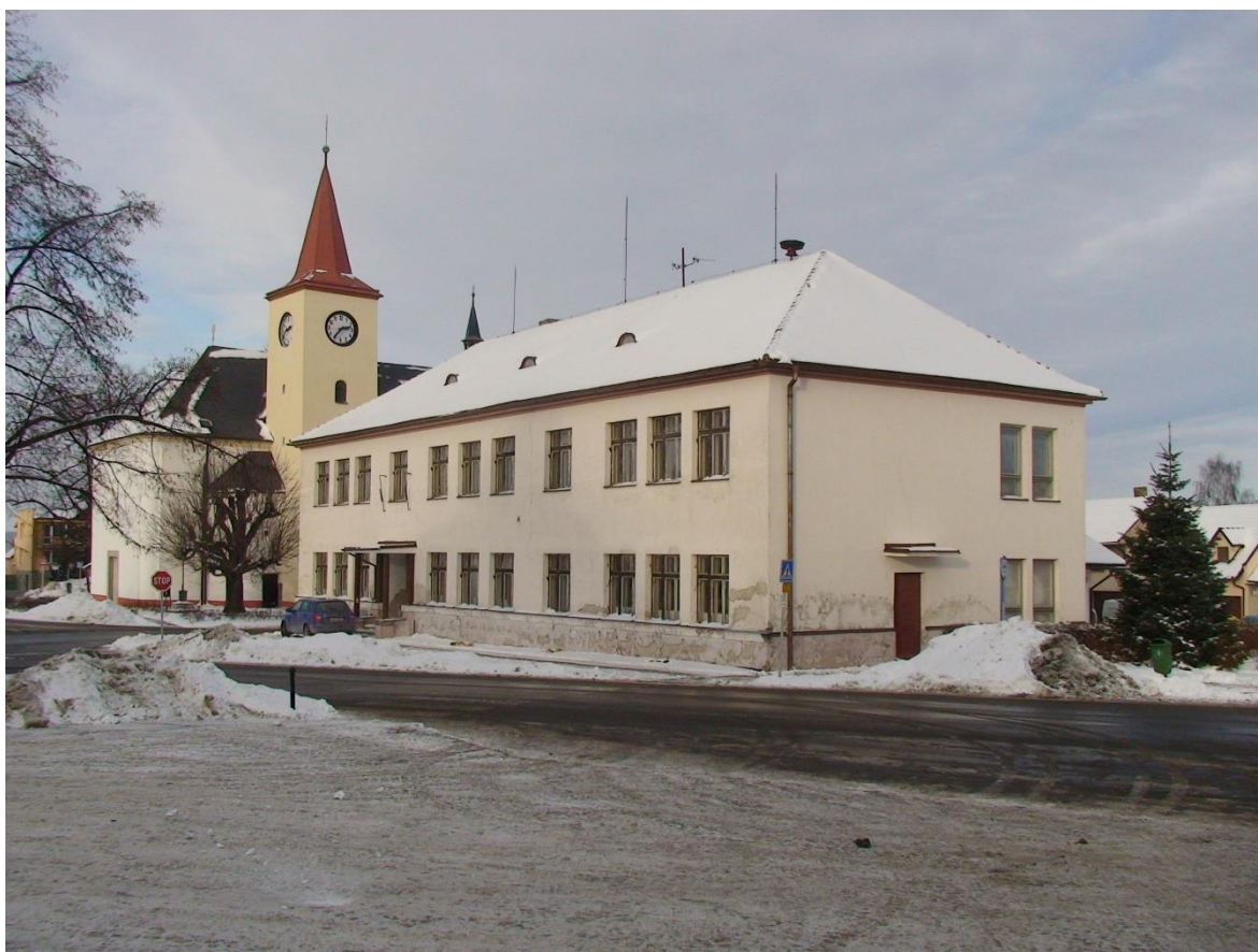
Obrázek 22 - Historická školní budova před demolicí v roce 2017
