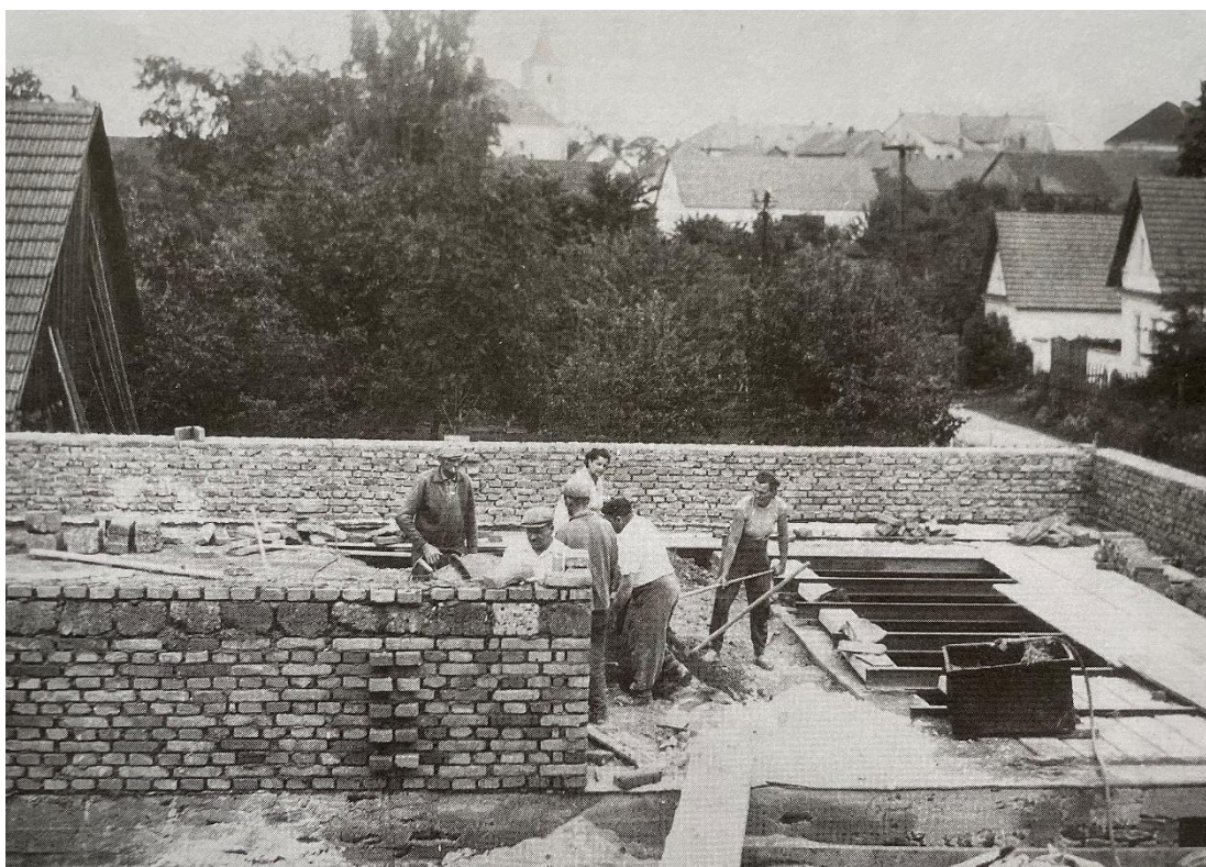
Obrázek 19 - Fotografie ze stavby školní jídelny v 60. letech
