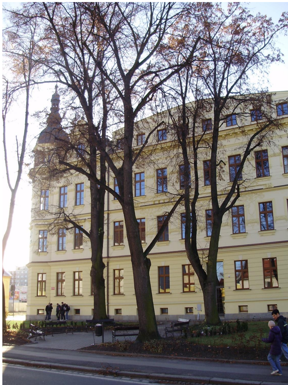
Obr. 1.(Základní škola Husovo náměstí v Klatovech po rekonstrukci a transformaci na bytový komplex v roce 2003)
