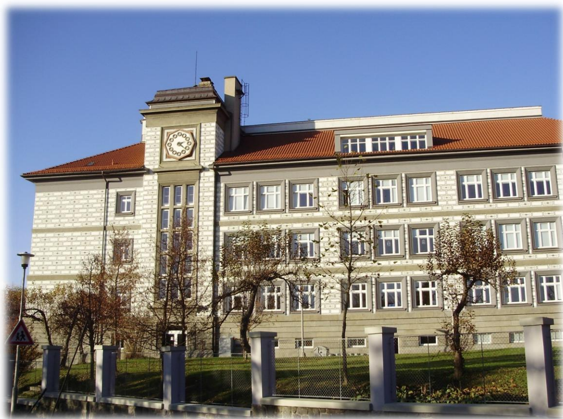
Obr. 4 (Budova Masarykovy základní školy v Klatovech)
