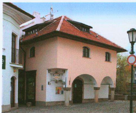
Foto 24. Dům čp. 2 v ulici Leopolda Pokorného v Třebíči
