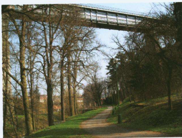
Foto 33. Železniční most přes Libušino údolí v Třebíči
