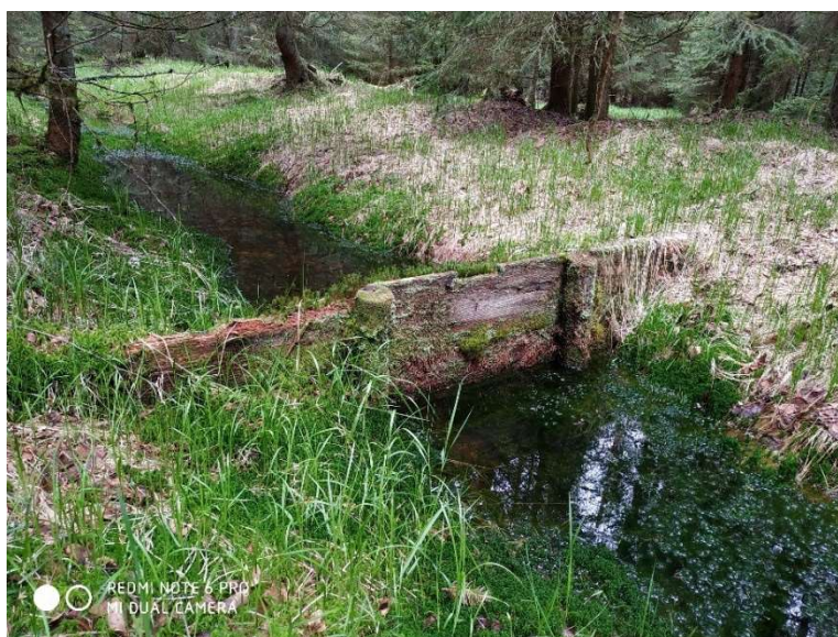
Obr. 4: Přehrazená odvodňovací rýha (foto: autor).
