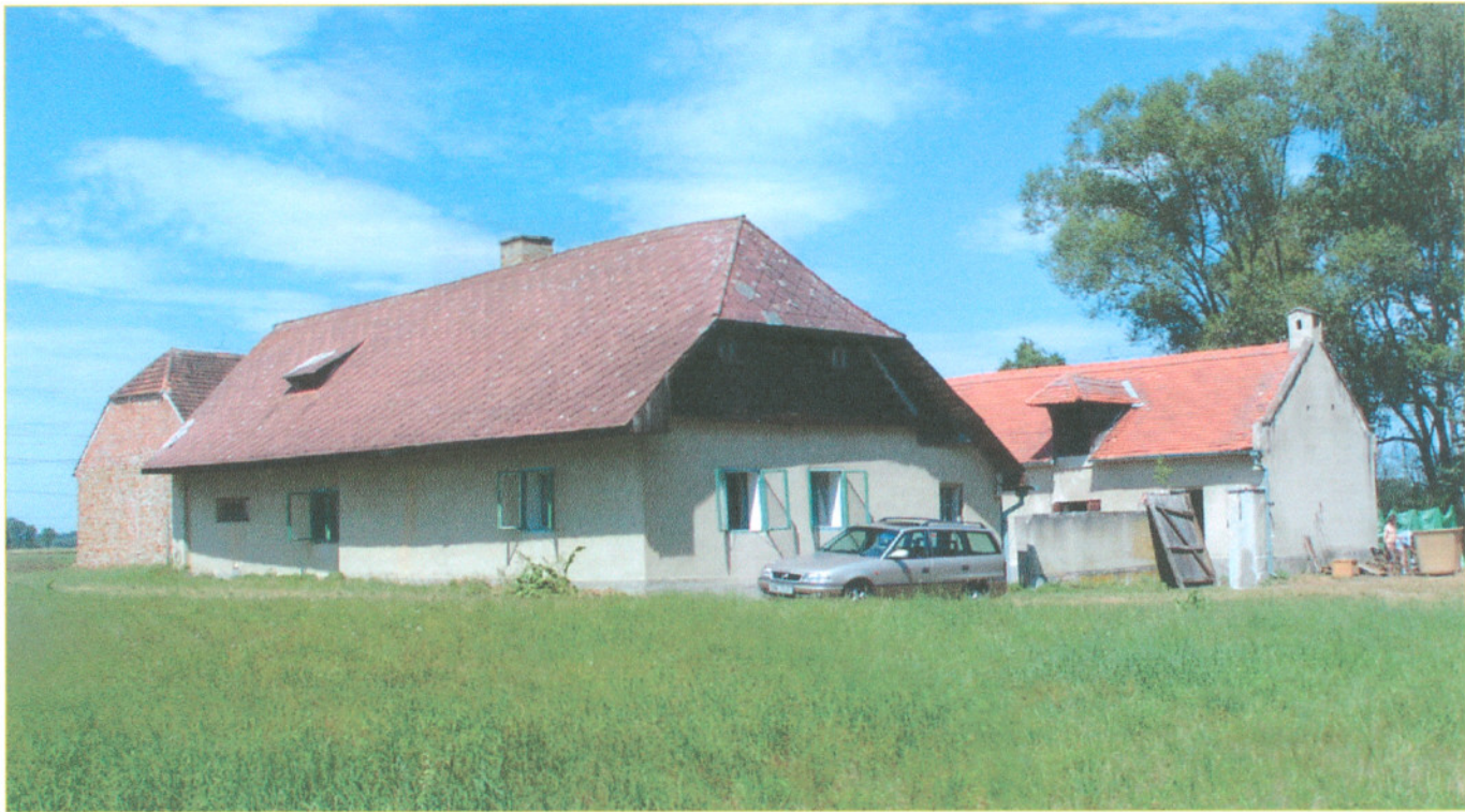
POHLED OD JIHOVÝCHODU - SOUČASNÝ STAV
