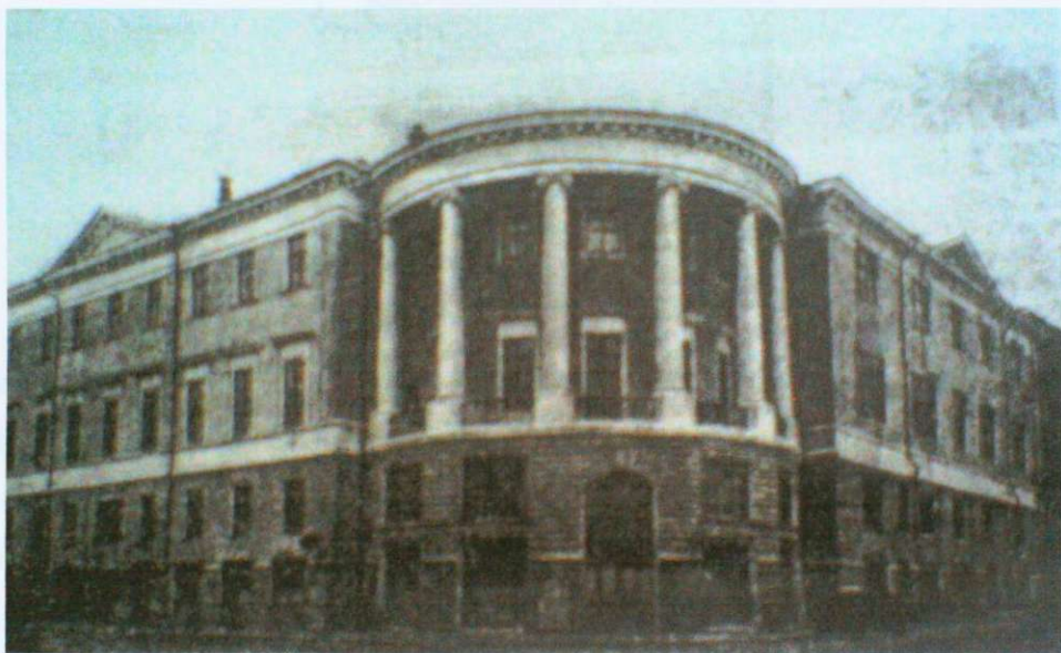
5. Dům I. I. Juškova. Celkový pohled
