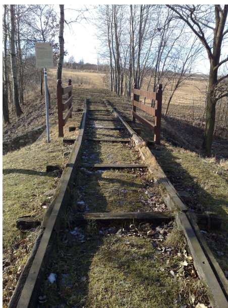
Obrázek 2 – Viadukt koněspřežné dráhy, Holkov
