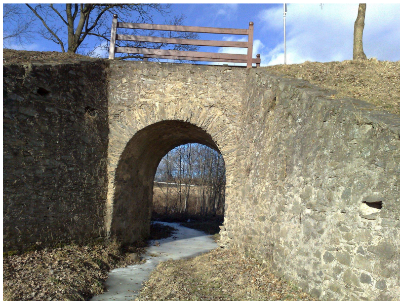
Obrázek 1 – Viadukt koněspřežné dráhy, Holkov
