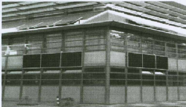
Obr. 3.4 instalace solárních článků na budově PRE.
