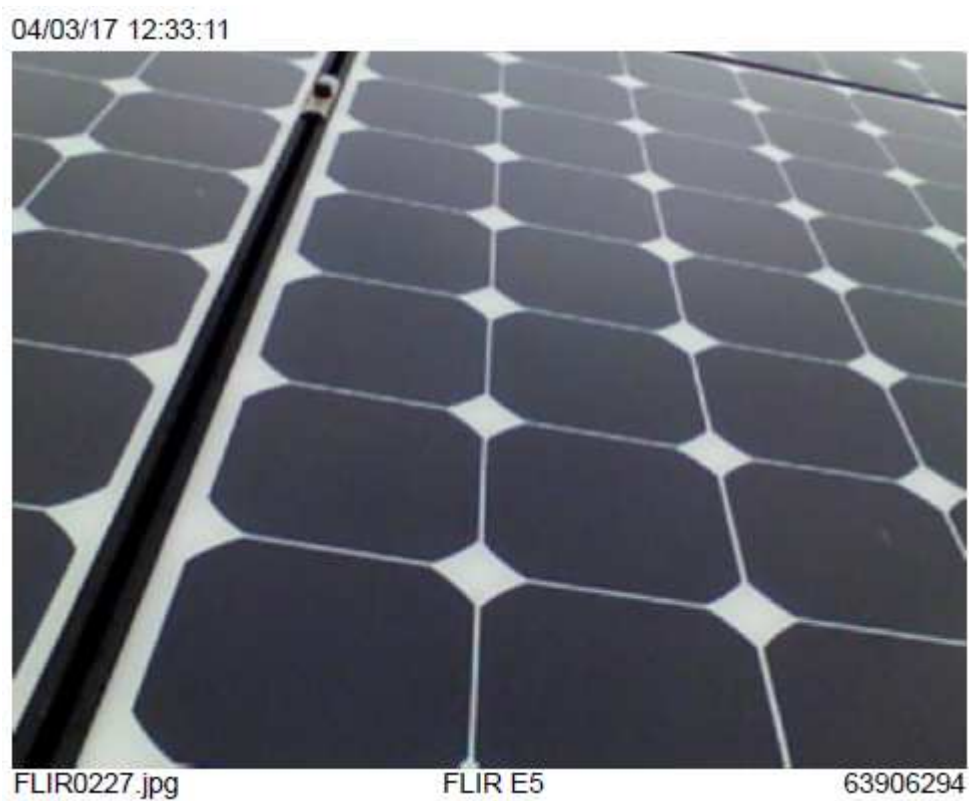
Obr. 7-16 Snímek 2, FVE 2, jižní strana
