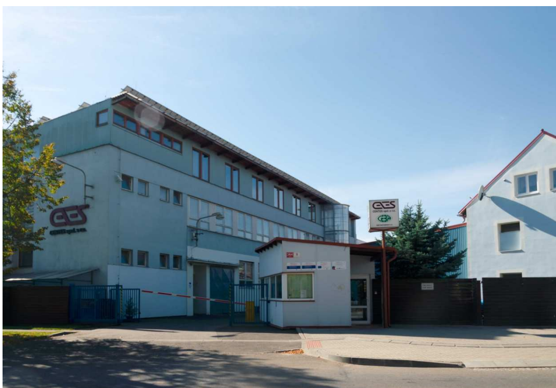
Obrázek 17: Hlavní budova společnosti
