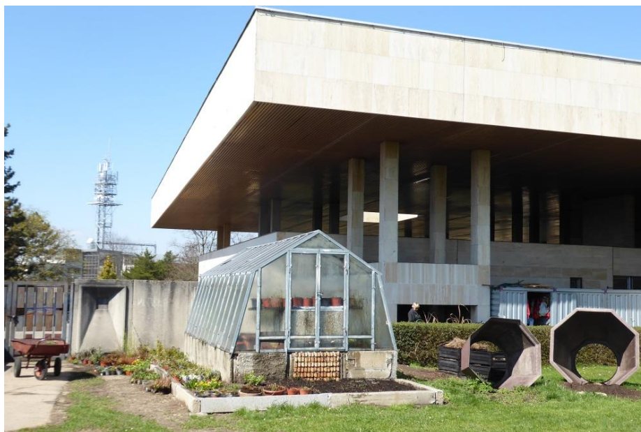
Obrázek 4.13: Skleník za technickým zázemím krematoria (zdroj: archiv PÚ)
