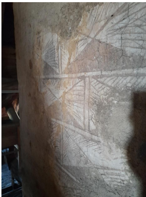
Obr. 67 Světlá nad Sázavou, detail sgrafitové výzdoby na komínovém tělese.
