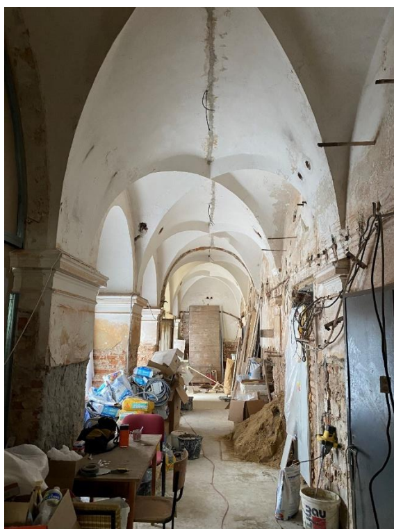
Obr. 71 Světlá nad Sázavou, průhled chodbou v přízemí s odhalenou renesanční výzdobou lunet, pohled od jihu.
