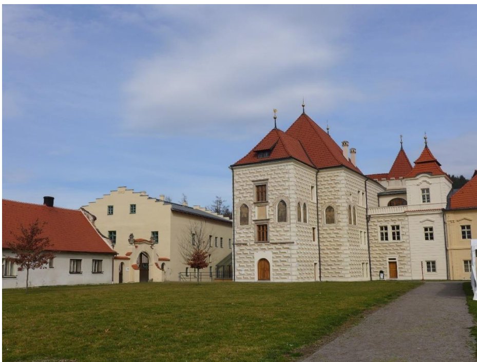
Obr. 103 Želiv, Trčkův hrad, jižní průčelí, pohled od jihovýchodu.
