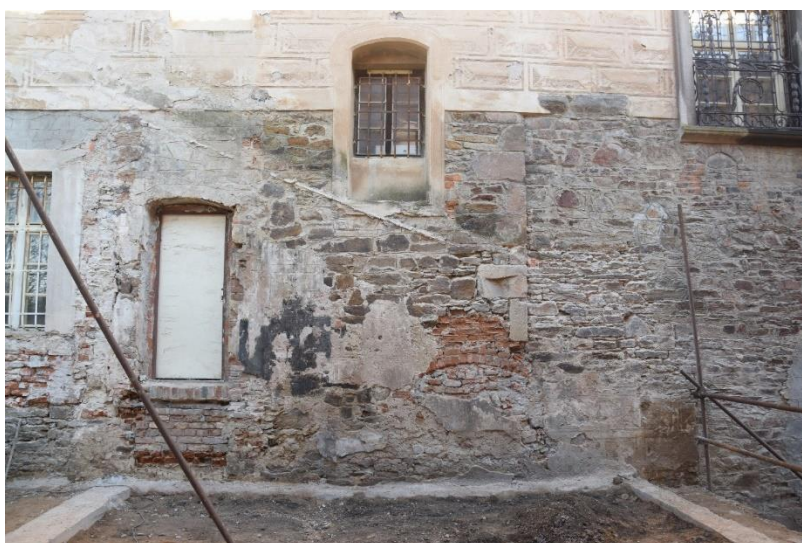
Obr. 108 Želiv, Trčkův hrad, pohled na odhalenou původní sgrafitovou výzdobu při rekonstrukci.
