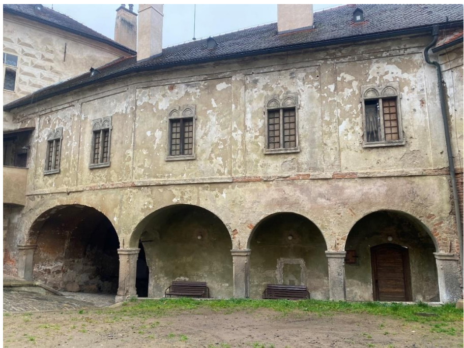
Obr. 40 Ledec nad Sázavou, pohled na arkádu dolního nádvoří hradu, pohled od východu.
