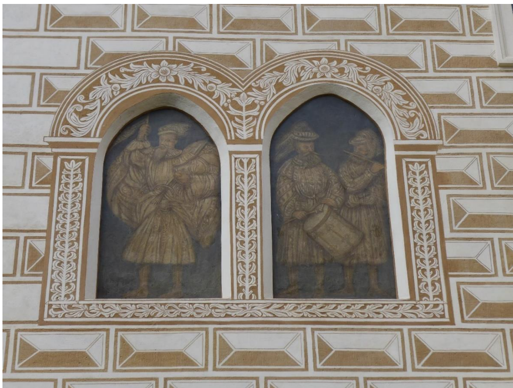
Obr. 111 Želiv, Trčkův hrad, obnovené figurální sgrafito východní strany hradu.
