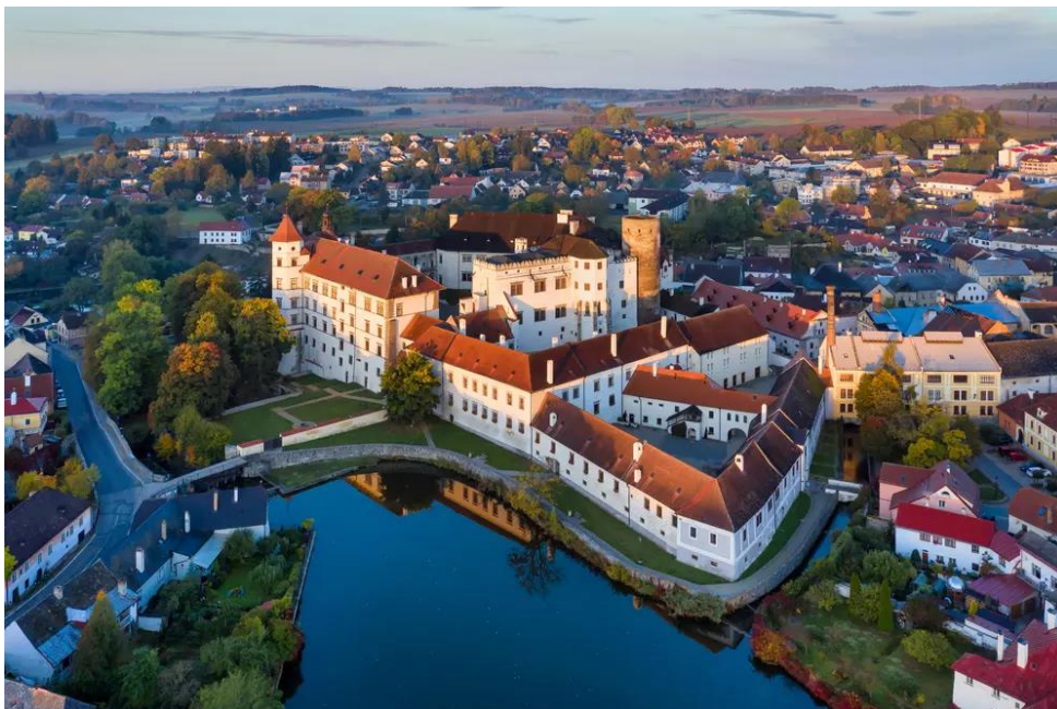
Obr. 121 Jindřichův Hradec, letecký snímek zámku.
