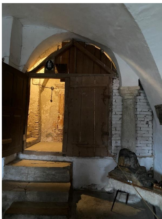
Obr. 34 Ledeč nad Sázavou, fragment pole arkády s toskánským sloupem.
