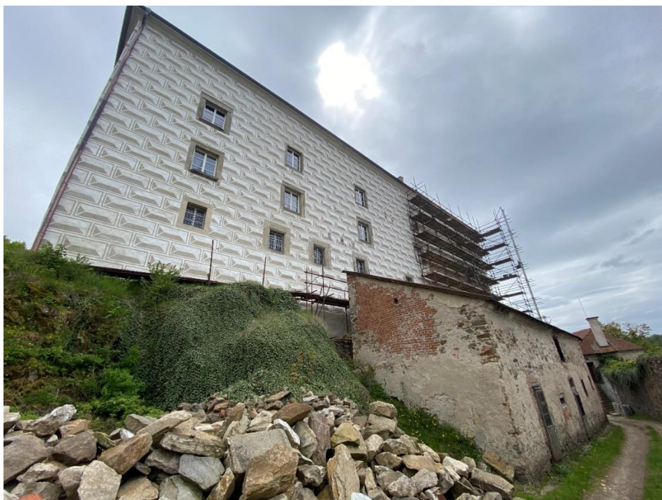
Obr. 21 Ledec nad Sázavou, pohled na severní fasádu hradu se sgrafitovou výzdobou.
