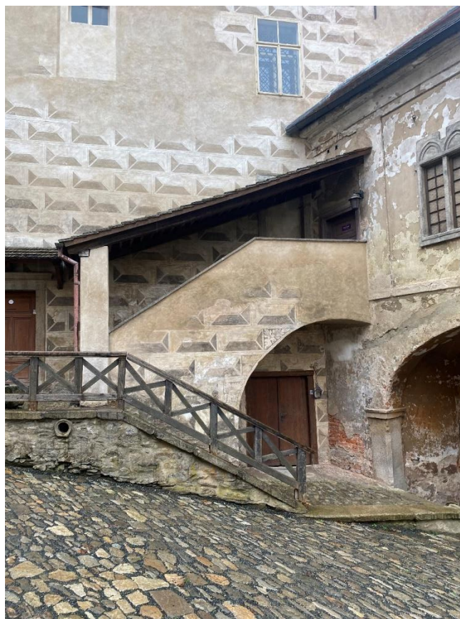
Obr. 48 Ledeč nad Sázavou, schodiště s přístřeškem na dolním nádvoří, sgrafito s akantovým polem, pohled od severu.
