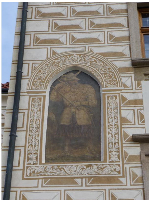
Obr. 115 Želiv, Trčkův hrad, obnovené figurální sgrafito jižního průčelí.
