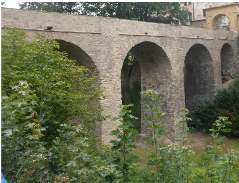
Obr. 50 Ledec nad Sázavou, dnešní podoba mostu, pohled od severovýchodu.
