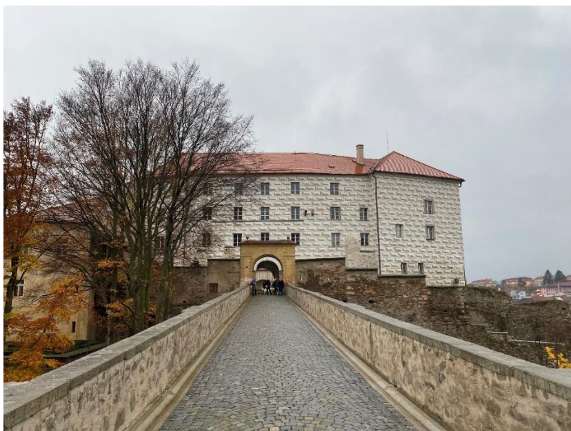
Obr. 19 Ledec nad Sázavou, pohled na průčelí tzv. velkého paláce od východu.
