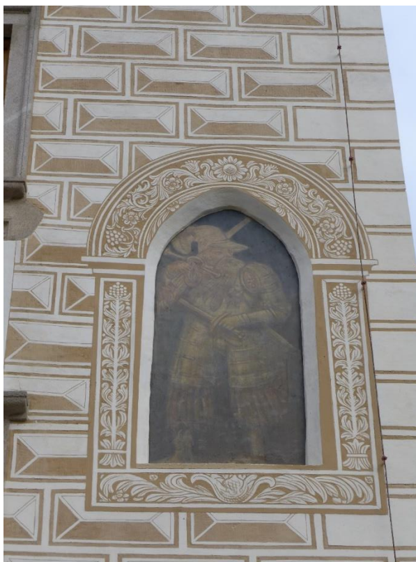
Obr. 114 Želiv, Trčkův hrad, obnovené figurální sgrafito jižního průčelí.
