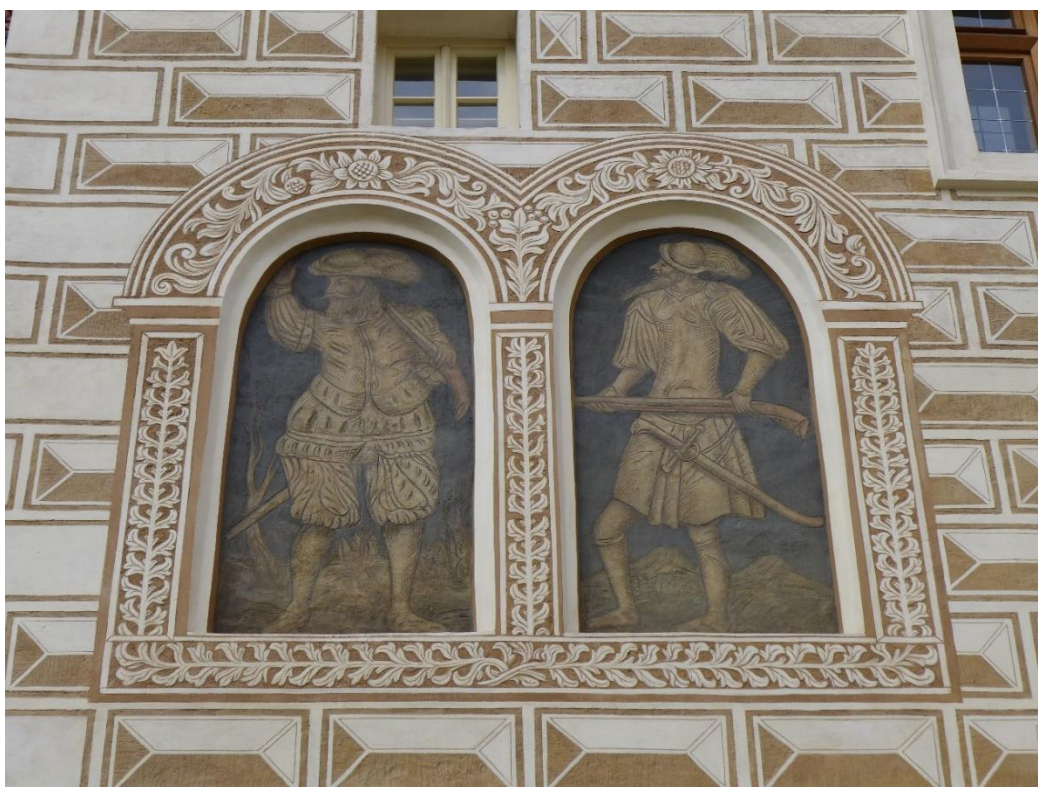
Obr. 112 Želiv, Trčkův hrad, obnovené figurální sgrafito východní strany hradu.
