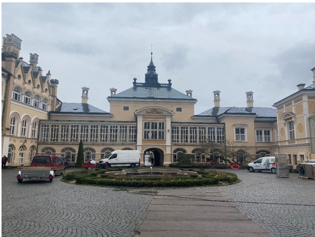
Obr. 62 Světlá nad Sázavou, pohled na západní křídlo z nádvoří.
