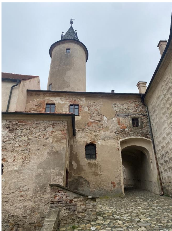
Obr. 45 Ledeč nad Sázavou, pohled křídlo s průjezdem z dolního nádvoří na horní nádvoří.
