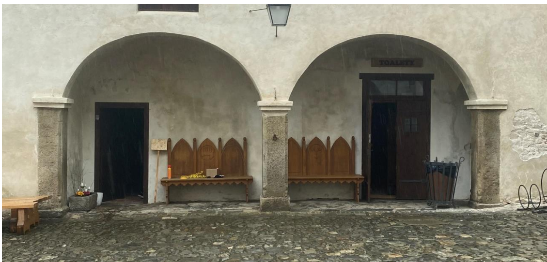
Obr. 27 Ledeč nad Sázavou, detail arkády s kamennými pilíři, pohled od východu.
