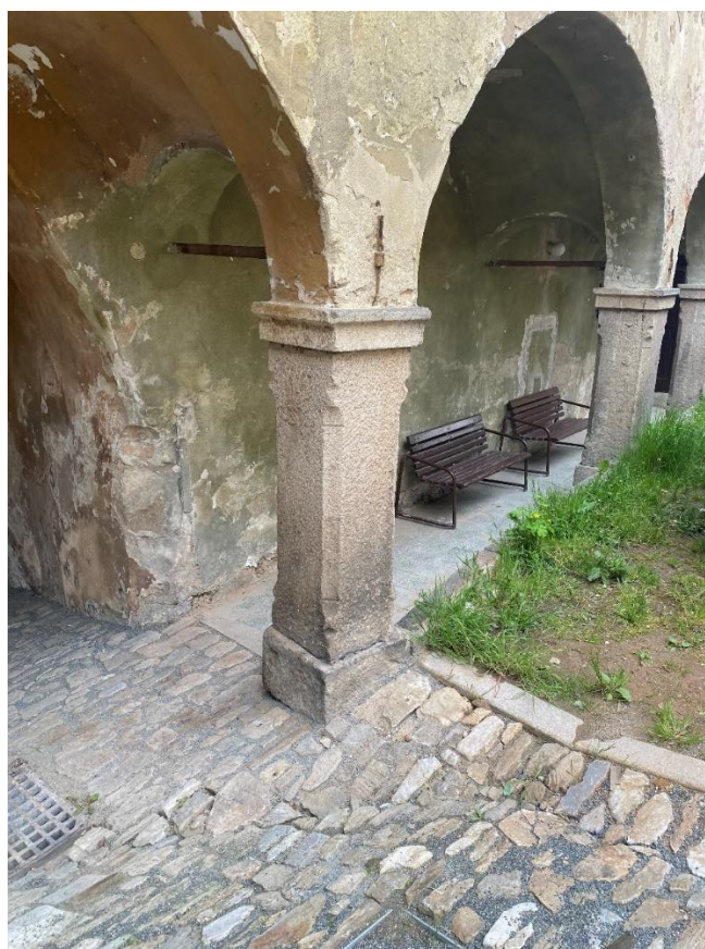
Obr. 42 Ledec nad Sázavou, okosený hranolový sloup arkády, pohled od jihovýchodu.
