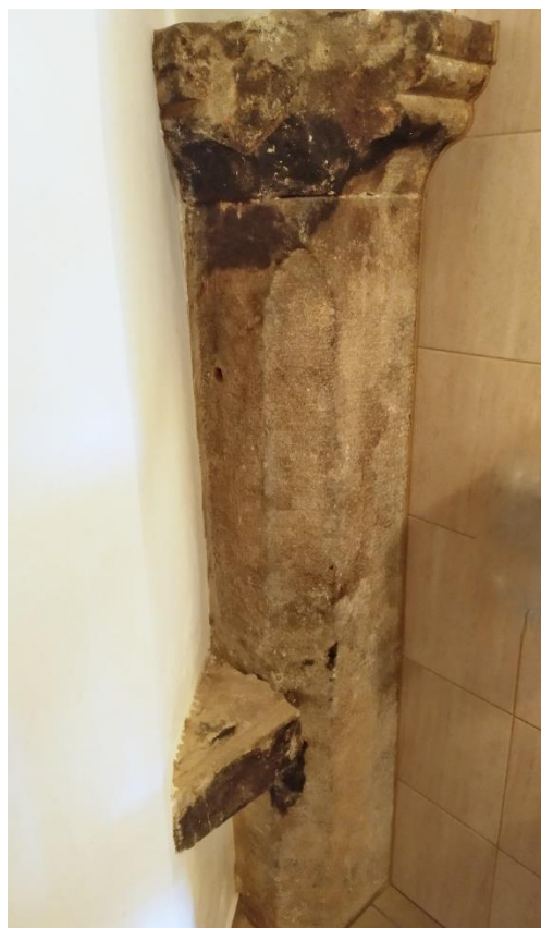
Obr. 68 Světlá nad Sázavou, detail renesančního pilíře v západním křídle zámku.
