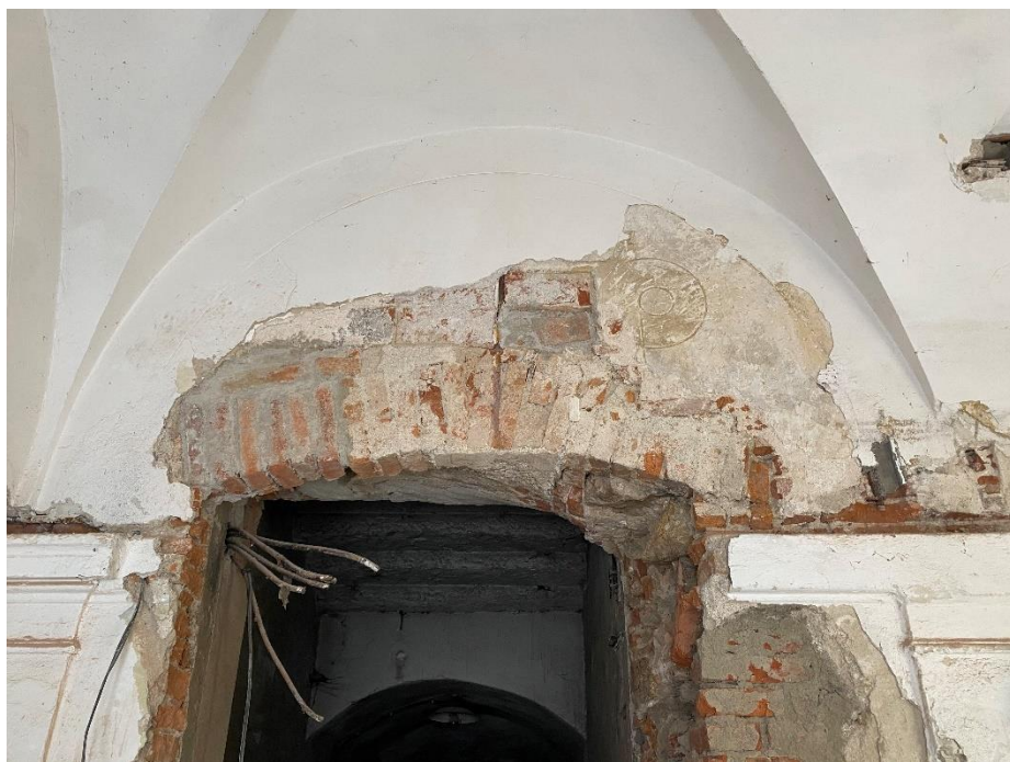
Obr. 72 Světlá nad Sázavou, detail částečně odkryté renesanční výzdoby lunet.
