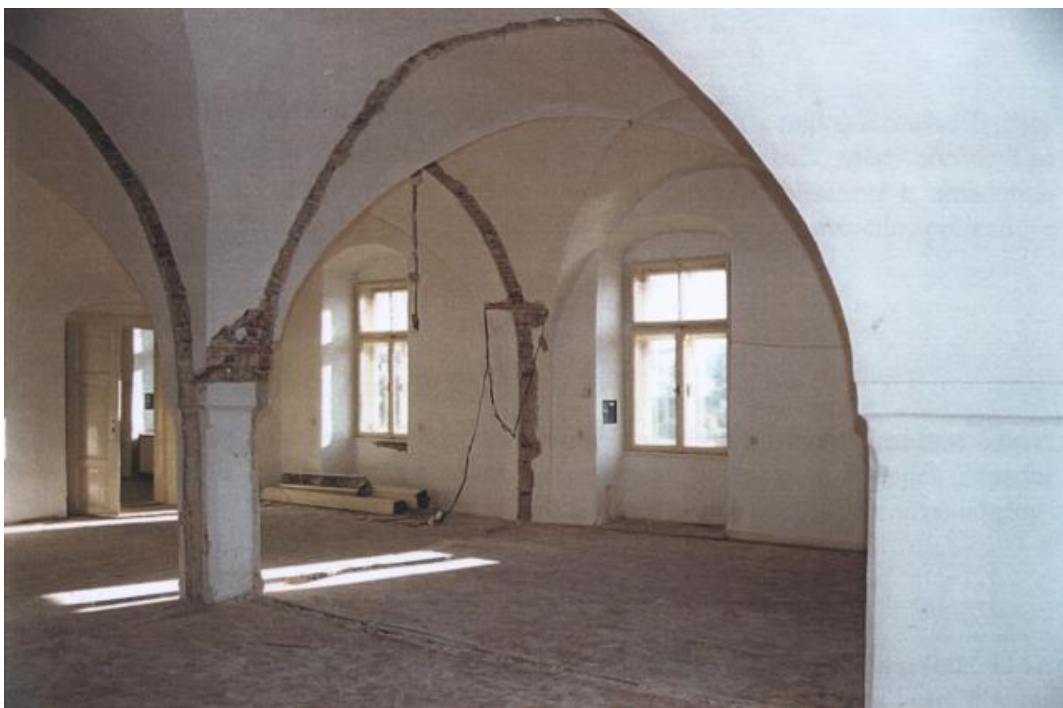
Obr. 43 Ledeč nad Sázavou, dvoulodí hřebínkových kleneb jižního křídla s kamennými pilíři.
