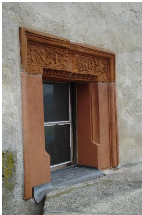
Obr. 31 Ledeč nad Sázavou, detail okna altánu s terakotovým ostěním, pohled od jihozápadu.
