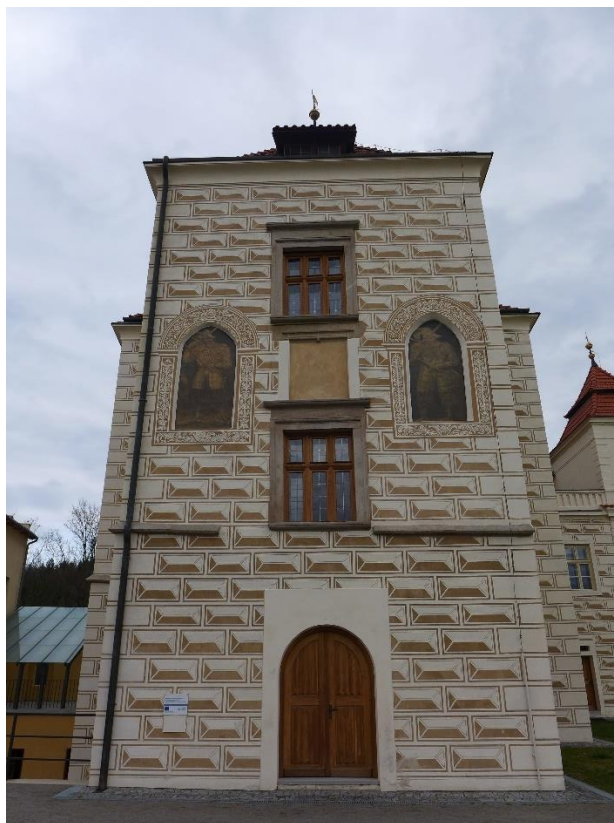
Obr. 105 Želiv, Trčkův hrad, pohled na jižní průčelí hradu.
