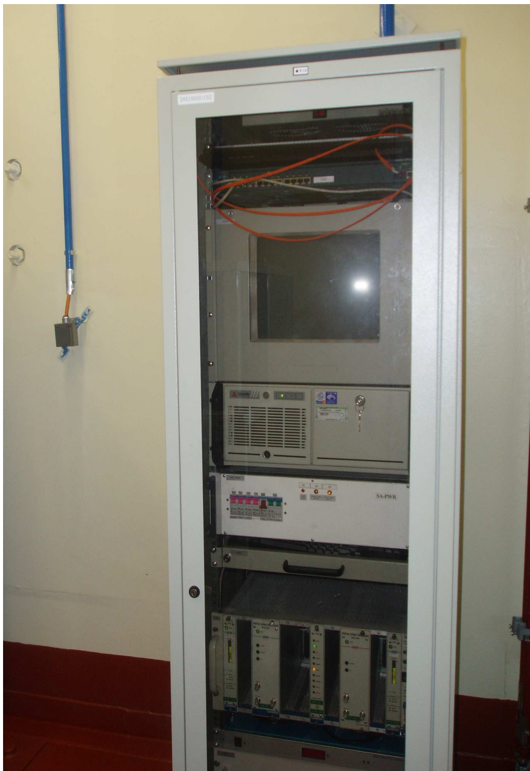
Obr. 5b: ovládací jednotka monitoru vzácných plynů-MVP, místnost AK1012, objekt HVB1,2
