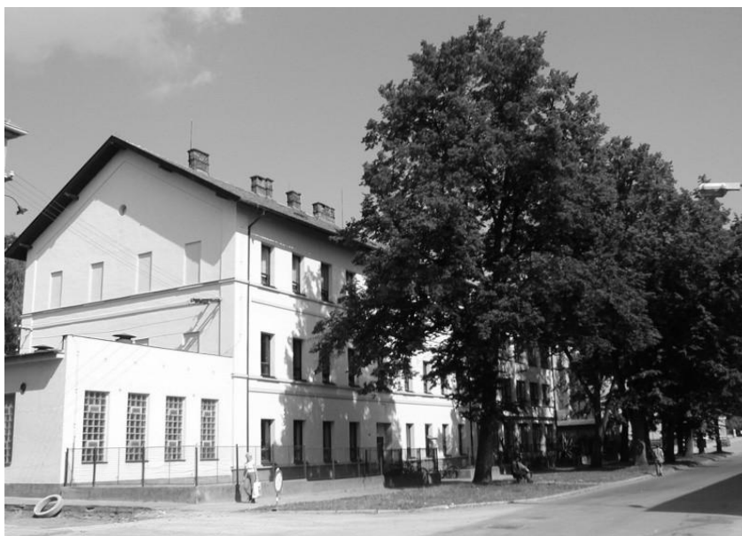
Obr. 14 Budova učiliště po rekonstrukci
