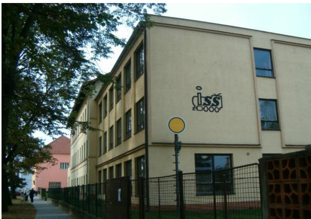
Obr. 20 Modernizovaná budova ISS České Velenice
