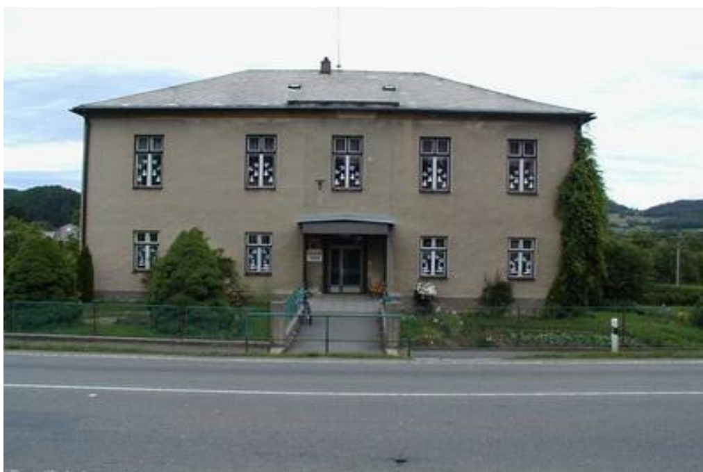
Obr. 19 Budova školy v Českých Budějovicích
