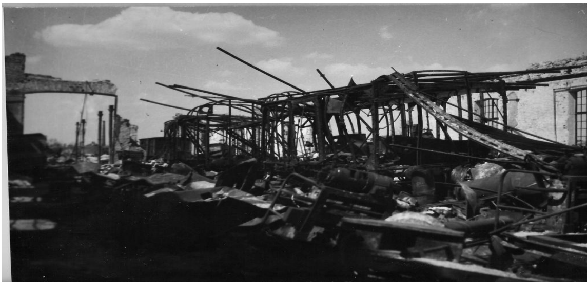
Obr. 6 Zničené školní dílny v ŽOS Č.V. po spojeneckých náletech
