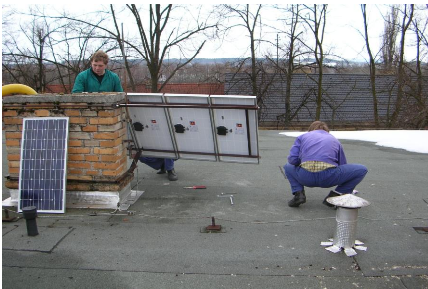
Obr. 33 montáž FV modulů
