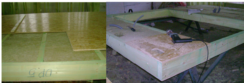
Obr. 47: Opláštění rámové konstrukce včetně tepelné izolace a flexibilů pro elektriku
