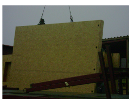
Obr. 48: Nakládka panelů na nákladní auto
