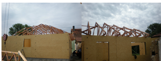
Obr. 52: Montáž krovu – vazníkové konstrukce
