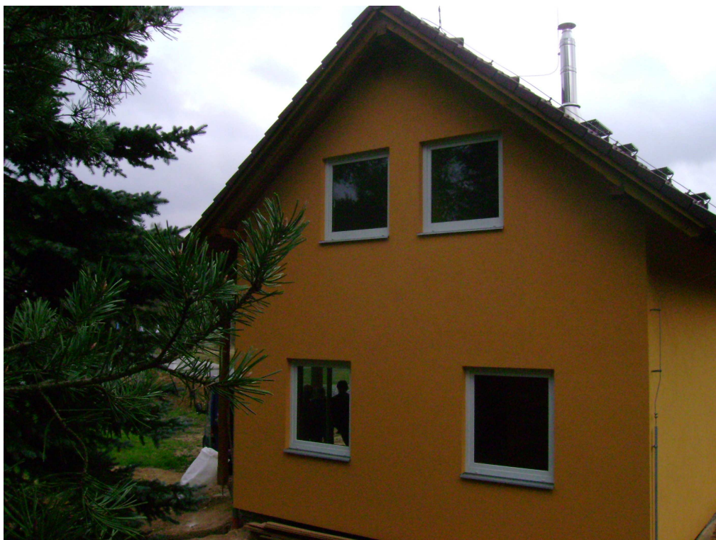
Obr. E: Panelová stavba Plzeň
