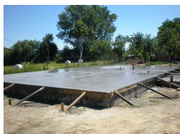
Obr. 49: Montáž základové desky
