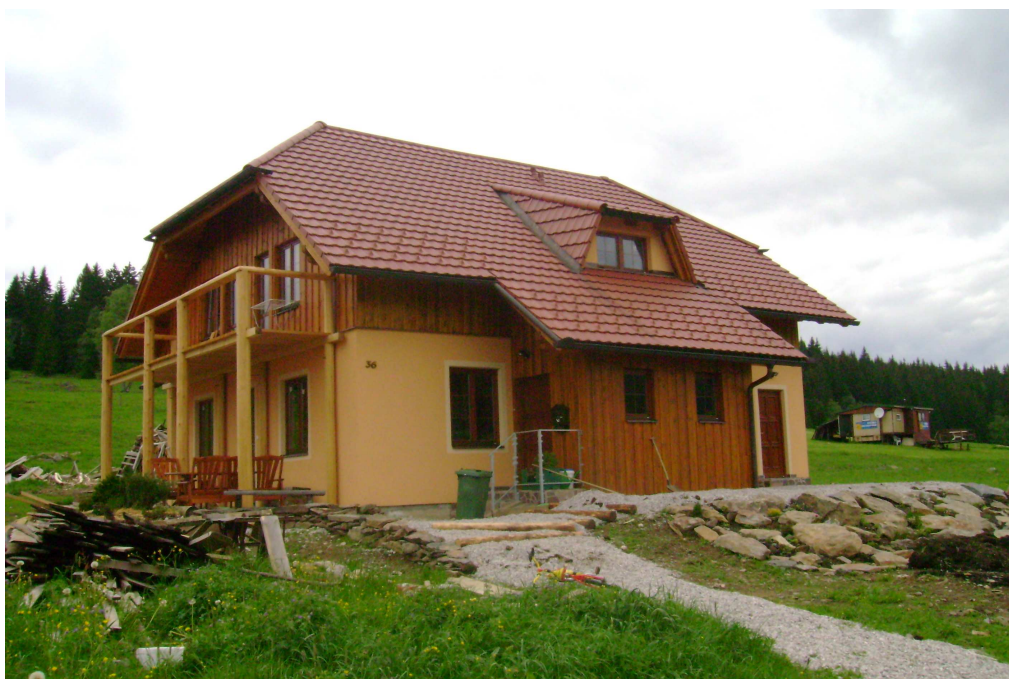
Obr. F: Panelová stavba Kvilda
