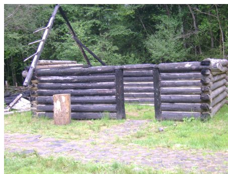
Obr. 4: Rekonstrukce roubeného srubu
