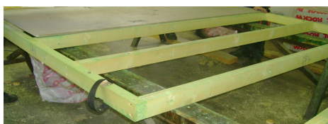
Obr. 46: Opláštění rámu z jedné strany OSB deskami
