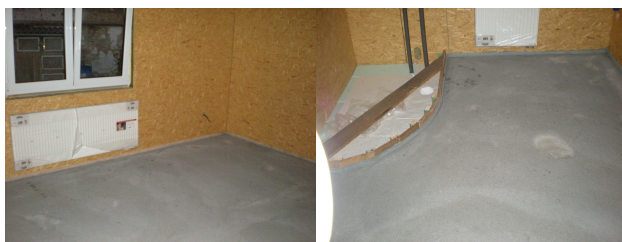
Obr. 59: Betonáž čistých podlah včetně pokládky tepelné izolace
