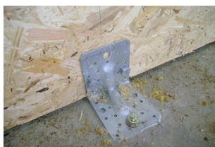
Obr. 51: Přikotvení panelové konstrukce k základové desce
