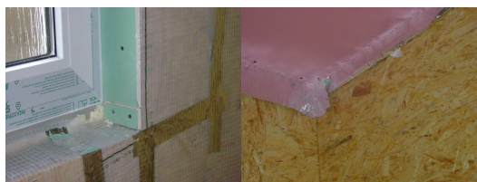
Obr. 60: Montáž parozábrany včetně sádrokartonových desek
