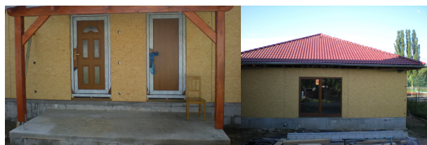
Obr. 56: Montáž oken a dveří
