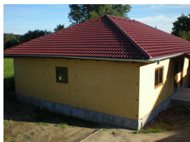
Obr. 54: Montáž střešních tašek
