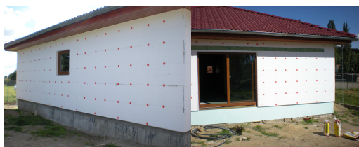
Obr. 57: Montáž fasádního systému
