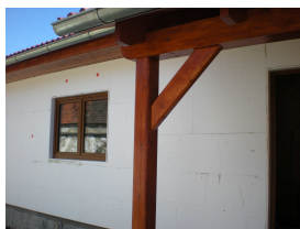
Obr. 55: Montáž podbití palubek
