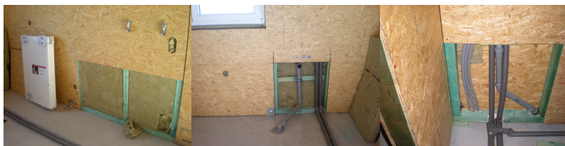
Obr. 58: Hrubé rozvody vody, elektroinstalace a topení
