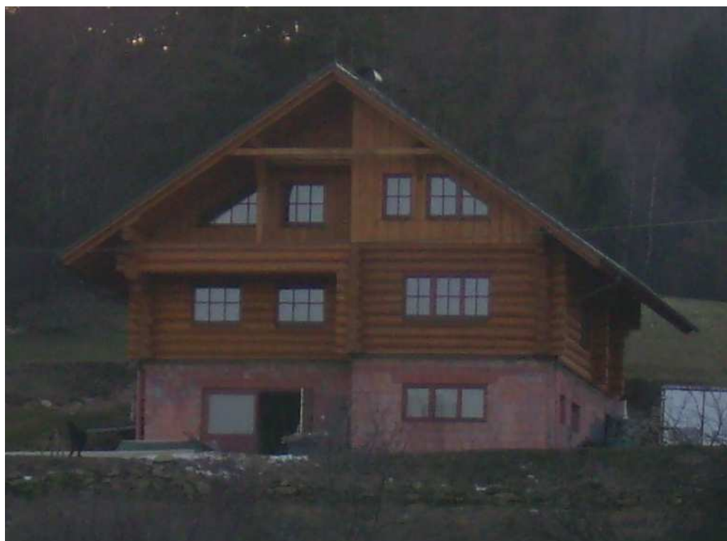
Obr. D: Srubová stavba Zlešice
