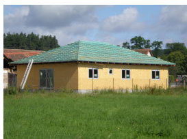
Obr. 53: Montáž difúzní fólie a latí
