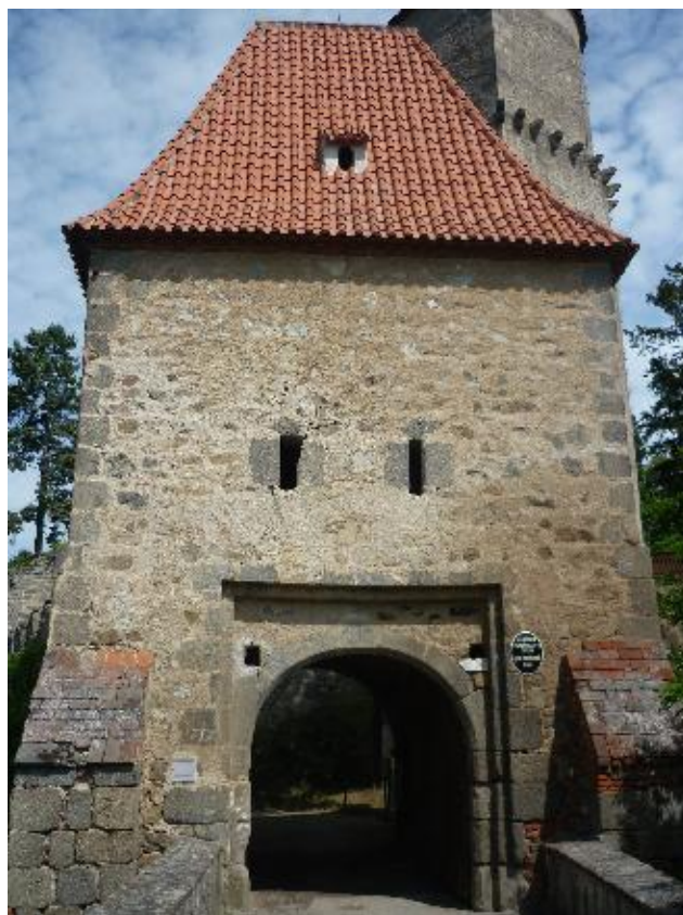
Obr. 11 – Písecká brána, pohled z jihu (foto autor ).
