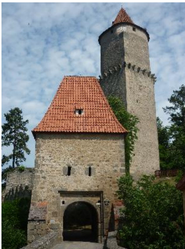
Obr. 15 – Věž s břitem (foto autor ).
