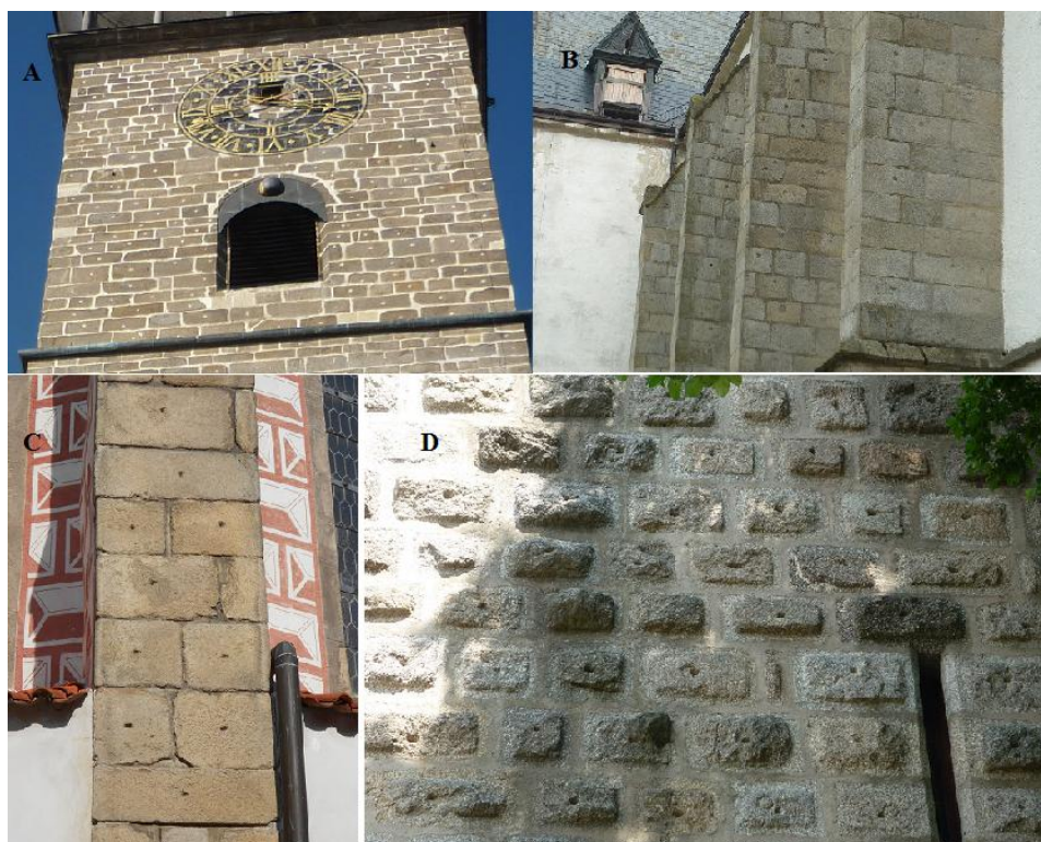
Obr. 34 – Kvádry opatřené důlky pro zvedací kleště. A: Černá věž, České Budějovice; B: Cisterciácký klášter, Vyšší Brod; C: Děkanský kostel sv. Bartoloměje, Pelhřimov; D: hrad Zvíkov, okr. Písek (foto autor).
