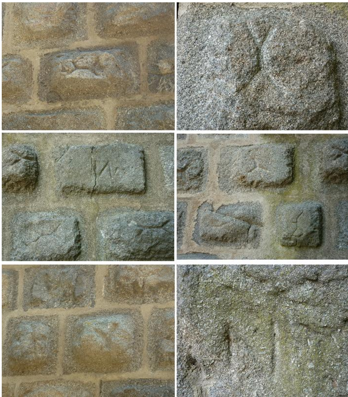
Obr. 32 – Kamenické značky na Hlízové věži (foto autor ).
