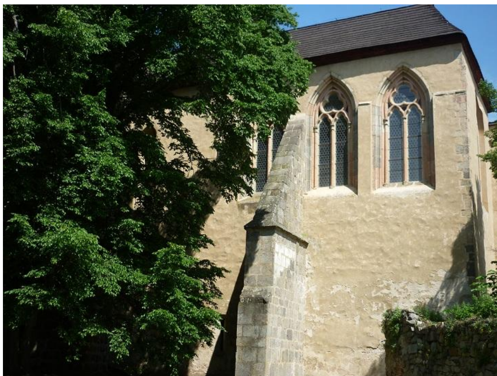
Obr. 28 – Kaple s velkým kružbovými okny (foto autor ).
