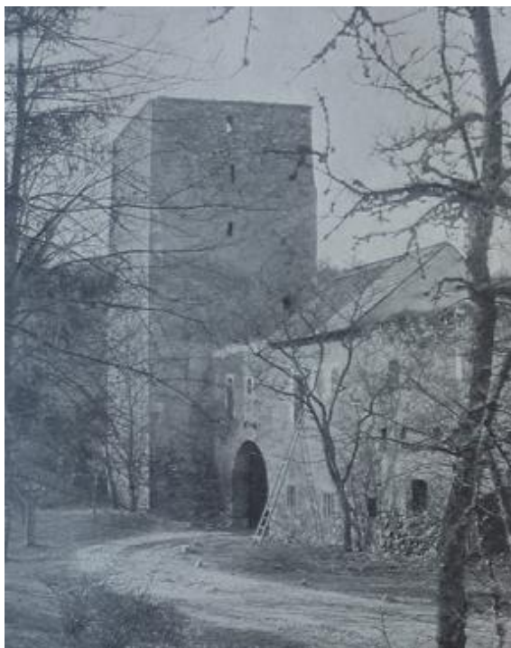
Obr. 22 – Červená věž před opravou (podle Soukup 1910, 384 ).
