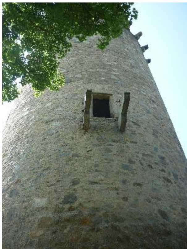
Obr. 17 – Vyvýšený vchod do věže Hláska (foto autor ).
