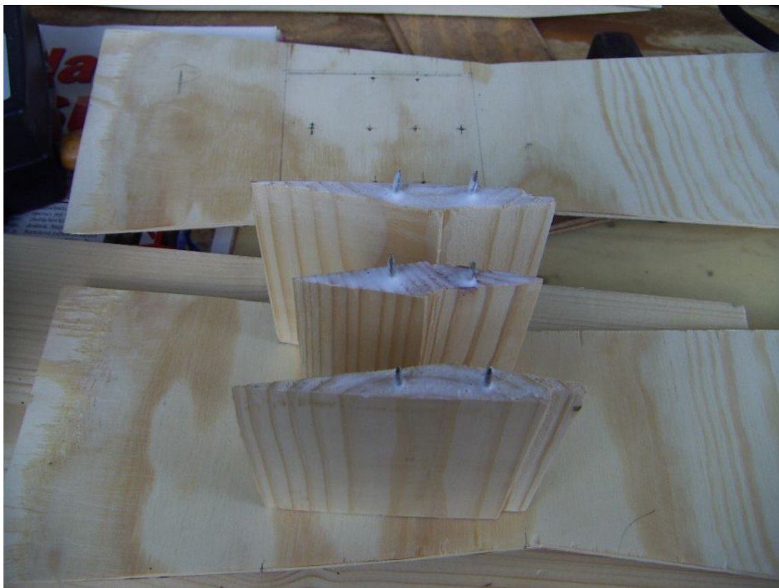
Obr. 6.2 – Uchycení jednotlivých difuzérů ke stěně komory
