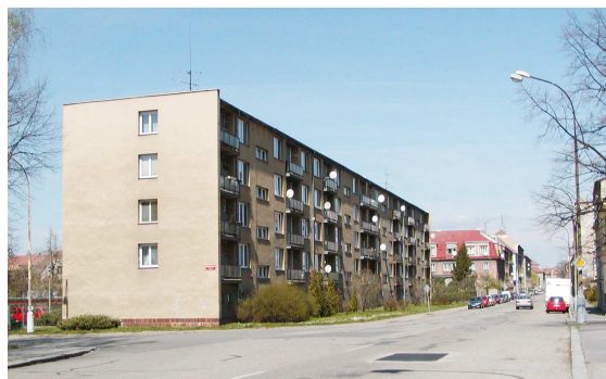
29. panelový dům 60. léta
