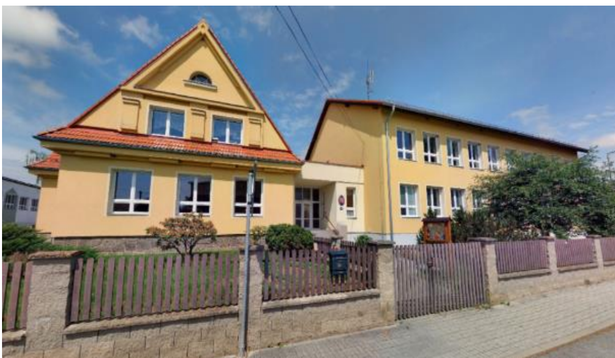
Foto 10. Neúplná větší venkovská Základní škola a Mateřská škola Dolní Dvořiště (okres Český Krumlov)
