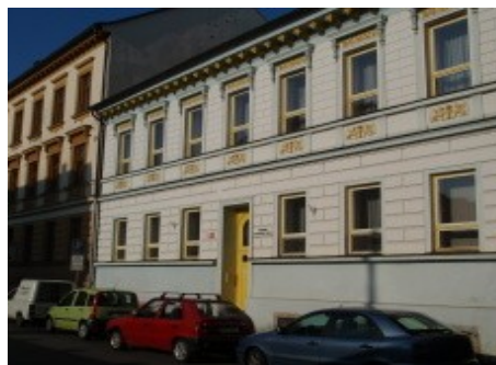
Obr. 13: Budova CMŠ Lipenská, České Budějovice
