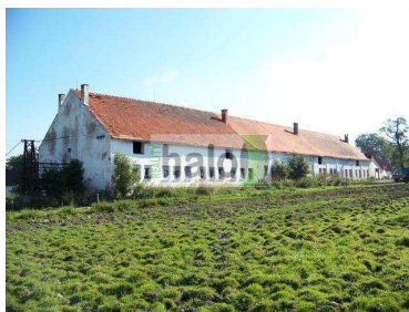
Obrázek 7.1: Zemědělský objekt v obci Pašice (HALO reality s.r.o)
