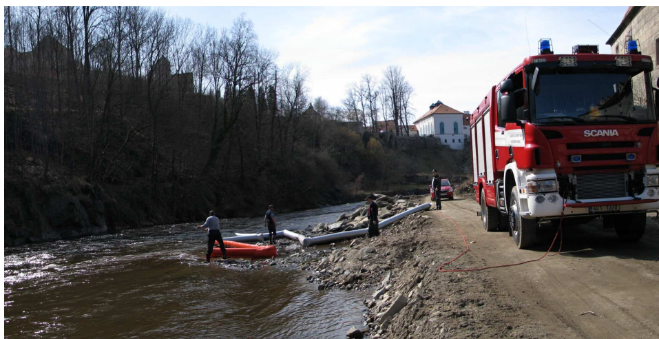
Obrázek č. 4: Instalace norných stěn na řece Vltava
