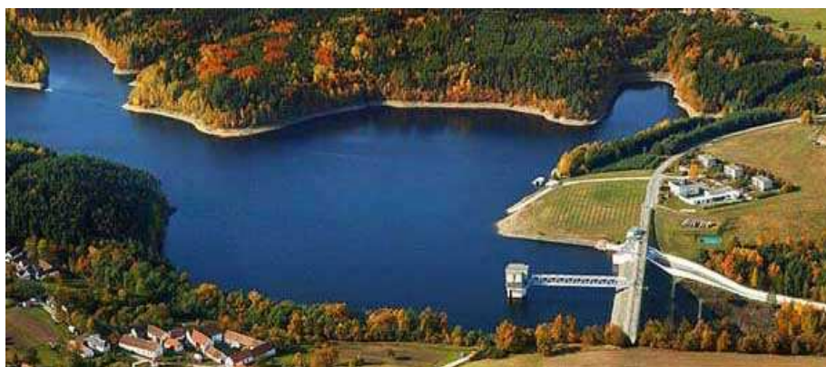
Obrázek č. 2: Koruna hráze VD Římov
