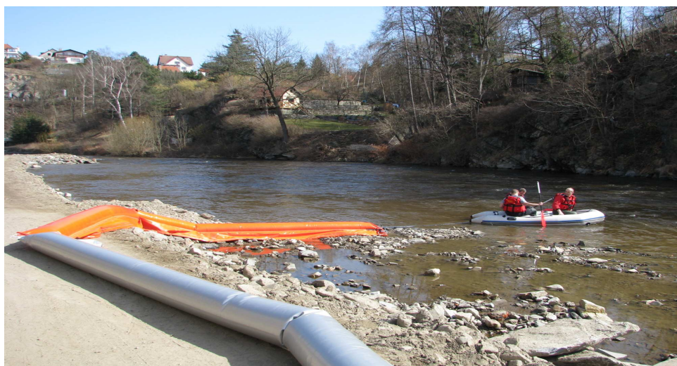
Obrázek č. 9: Nehoda bagru instalace - norných stěn
